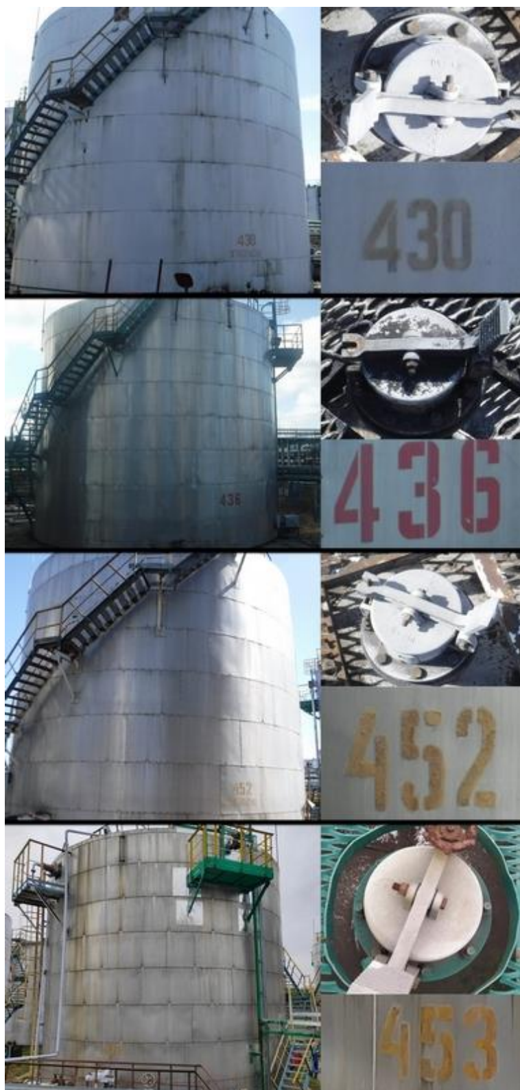
Рисунок 2 – Фотографии общего вида резервуаров стальных вертикальных цилиндрических РВС-700 (№№430, 436, 452, 453), горловин замерных люков и заводских номеров
