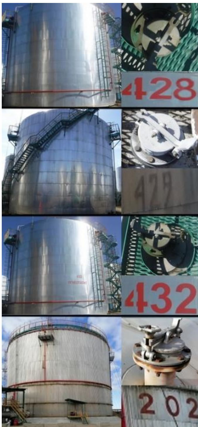
Рисунок 4 – Фотографии общего вида резервуаров стальных вертикальных цилиндрических РВС-2000 (№№428, 429, 432), РВС-10000 (№ 202), горловин замерных люков и заводских номеров
