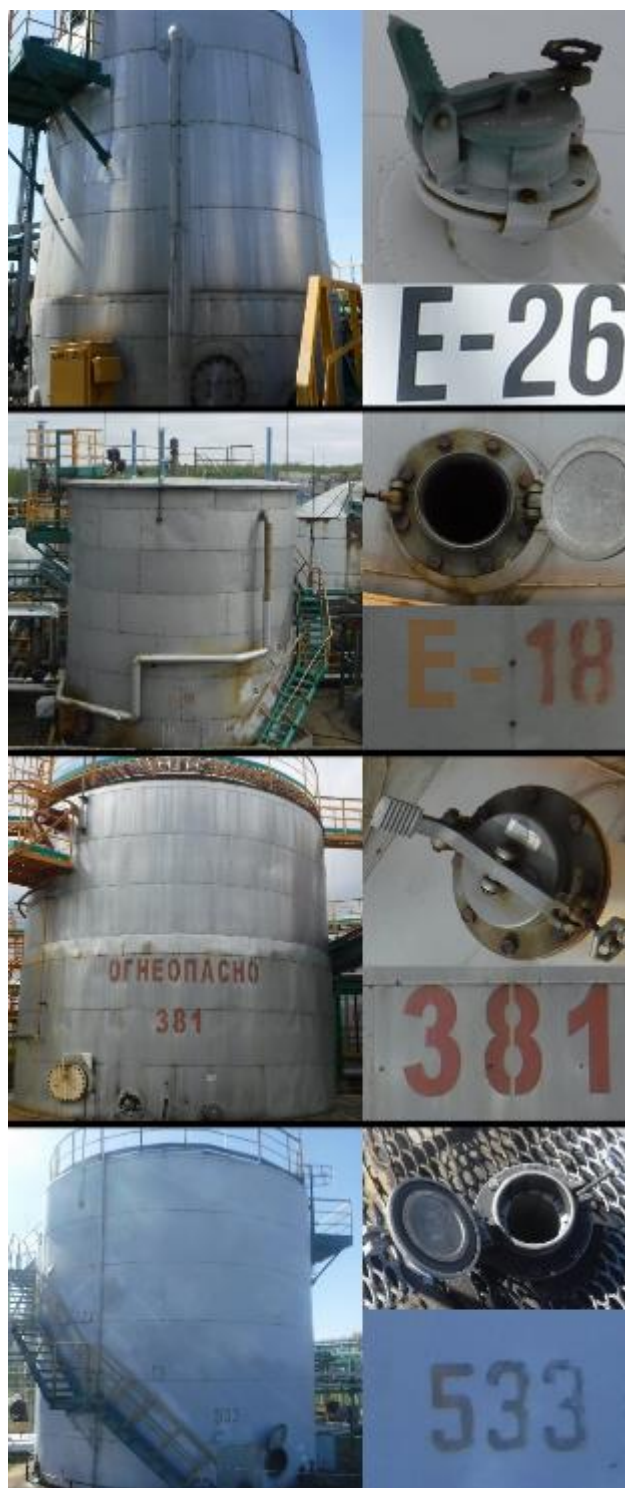
Рисунок 1 – Фотографии общего вида резервуаров стальных вертикальных цилиндрических РВС-100 (№ E-26), РВС-300 (№№ E-18, 533), РВС-400 (№ 381), горловин замерных люков и заводских номеров
