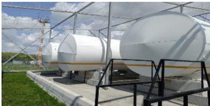
Рисунок 1. Общий вид резервуаров РГС-65 № 1 и № 2, РГС-75 № 3
