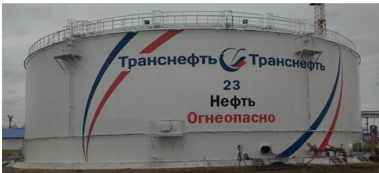
Рисунок 1 – Общий вид резервуара РВСП-20000 № 23
