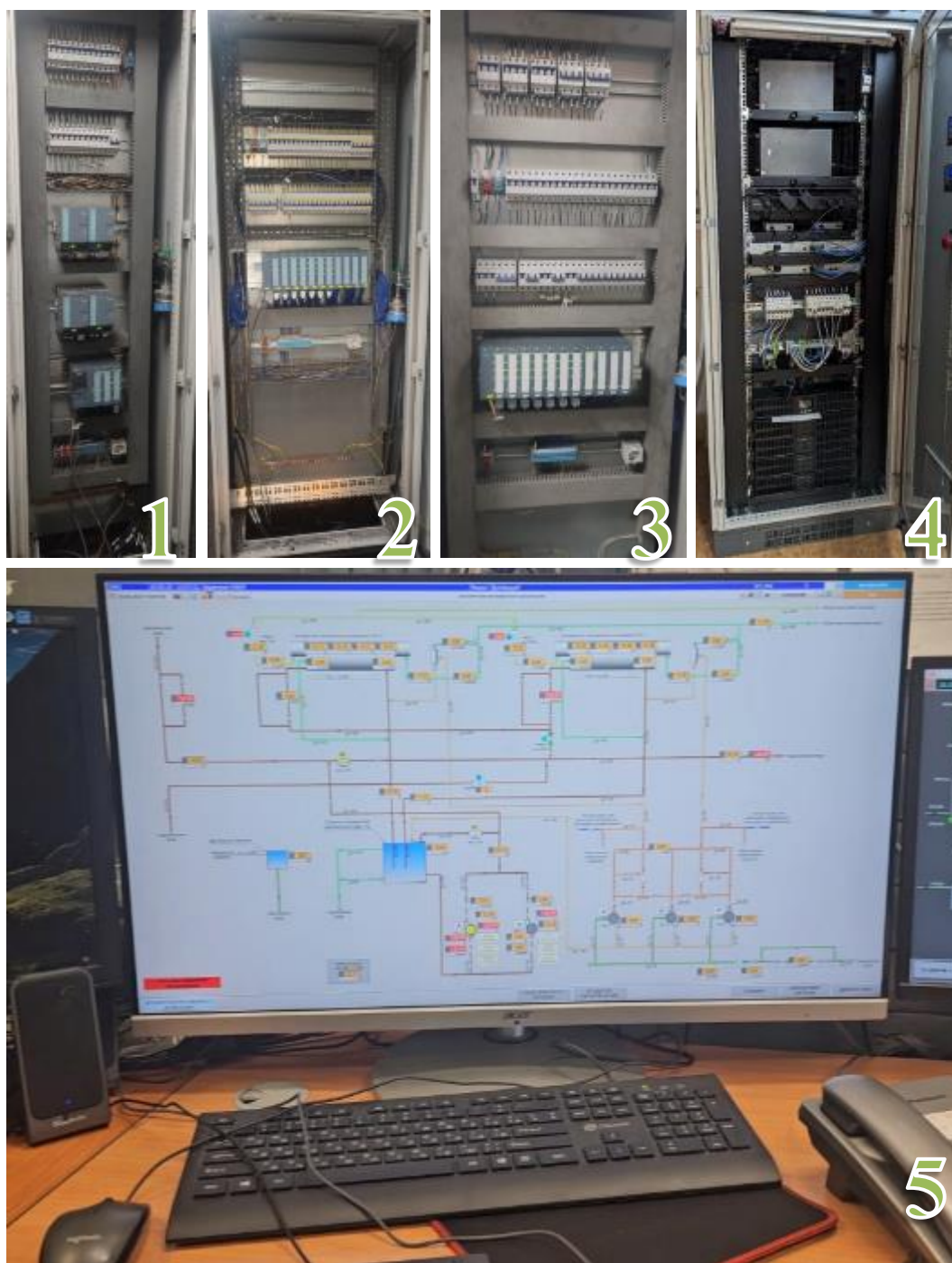
1 – Оборудование шкафа управления с ПЛК; 2, 3 – Оборудование шкафов управления с модулями аналогового ввода; 4 – Оборудование шкафа с ССОД; 5 – Экран автоматизированного рабочего места
