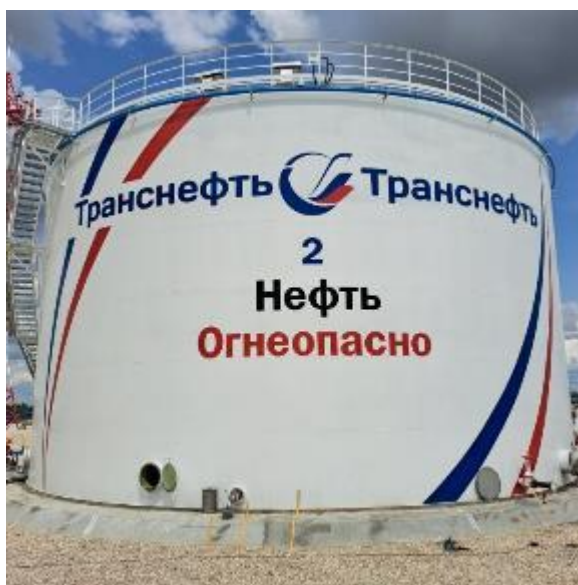
Рисунок 1 – Общий вид резервуара РВС-5000
