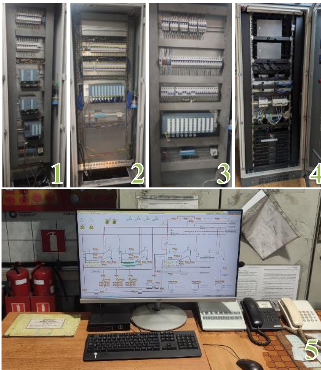
1 – Оборудование шкафа управления с ПЛК; 2, 3 – Оборудование шкафов управления с модулями аналогового ввода; 4 – Оборудование шкафа с ССОД; 5 – Экран автоматизированного рабочего места
