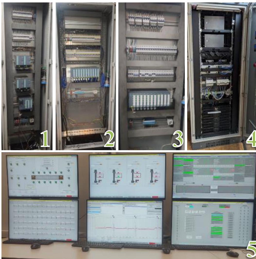
1 – Оборудование шкафа управления с ПЛК; 2, 3 – Оборудование шкафов управления с модулями аналогового ввода; 4 – Оборудование шкафа с ССОД; 5 – Экраны автоматизированного рабочего места.
