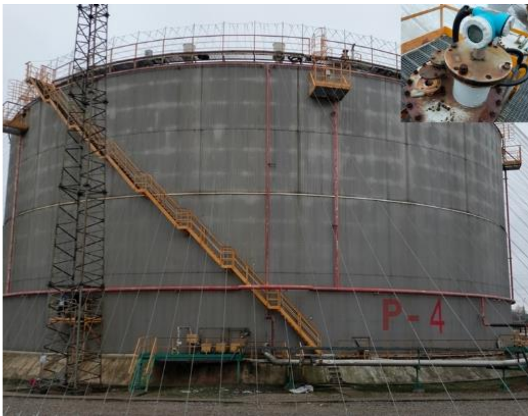
Рисунок 2 – Фотографии общего вида резервуара стального вертикального цилиндрического РВСП-30000 (№ Р-4), горловины замерного люка и заводского номера
