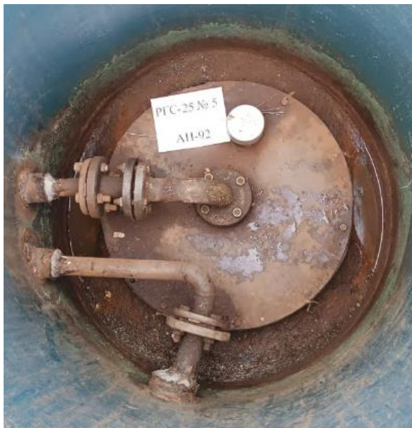
Рисунок 3 – Горловина резервуара РГС-25 зав.№ 5
