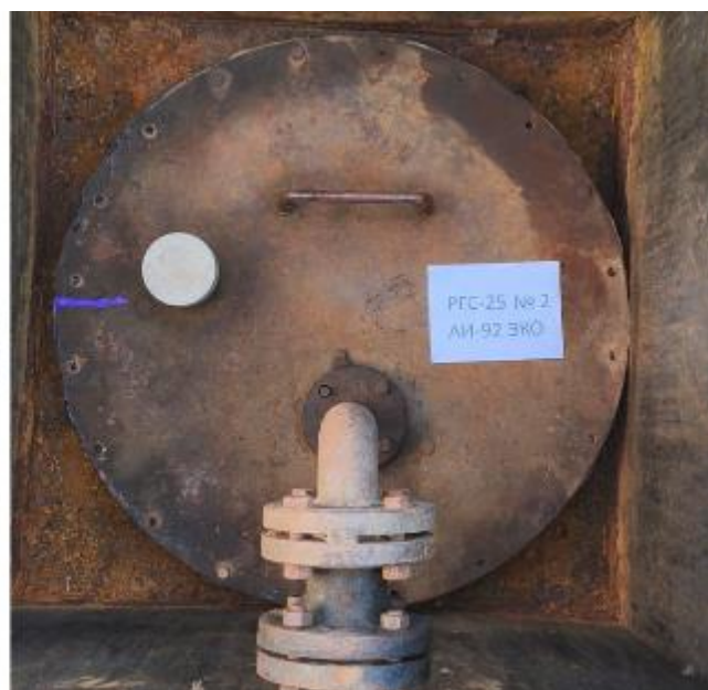
Рисунок 4 – Горловины резервуаров РГС-25 зав.№№ 1, 2
