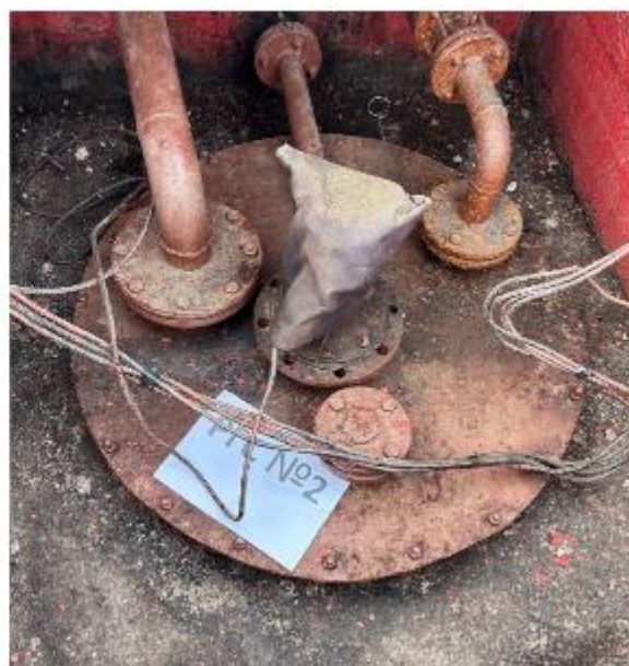
Рисунок 2 – Горловины резервуаров РГС-50 зав.№№ 1, 2
