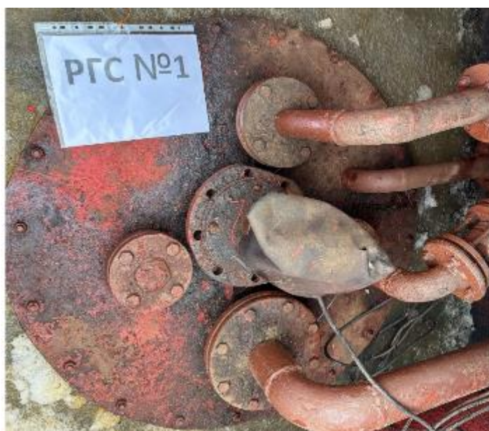
Рисунок 2 – Горловины резервуаров РГС-50 зав.№№ 1, 2
