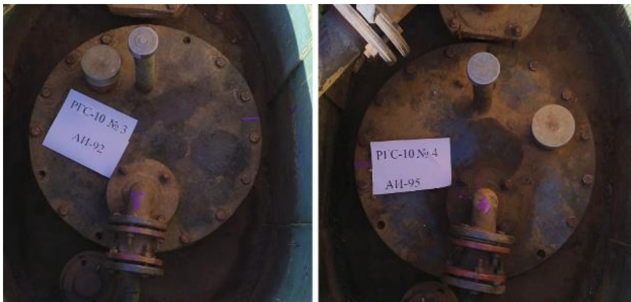
Рисунок 3 – Горловины резервуаров РГС-10 зав.№№ 3, 4
