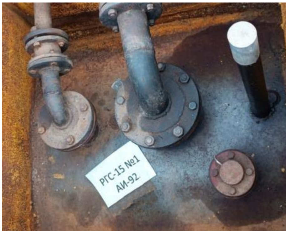
Рисунок 3 – Горловина резервуара РГС-15 зав.№ 1
