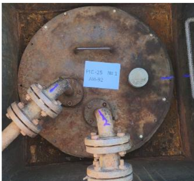
Рисунок 4 – Горловины резервуаров РГС-25 зав.№№ 1, 2
