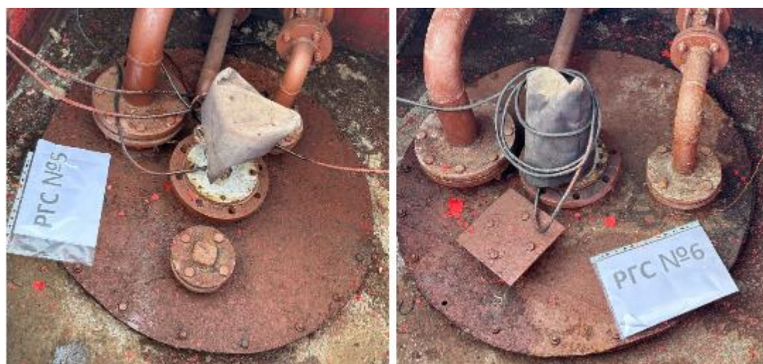
Рисунок 4 – Горловины резервуаров РГС-50 зав.№№ 5, 6
