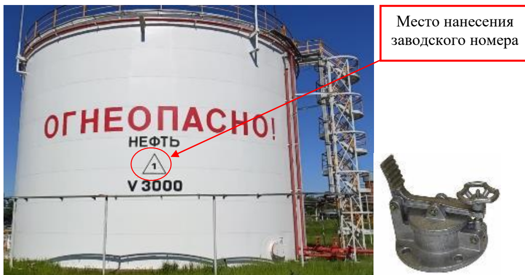
Рисунок 1 – Общий вид резервуара и замерного люка РВС-3000 зав. № 1
