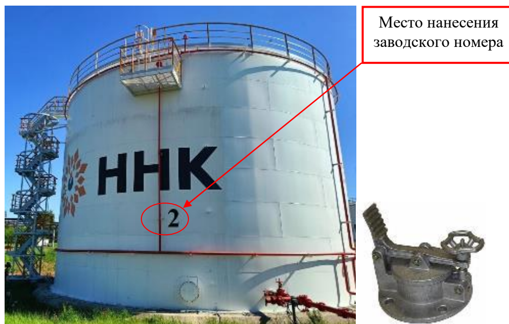
Рисунок 2 – Общий вид резервуара и замерного люка РВС-3000 зав. № 2
