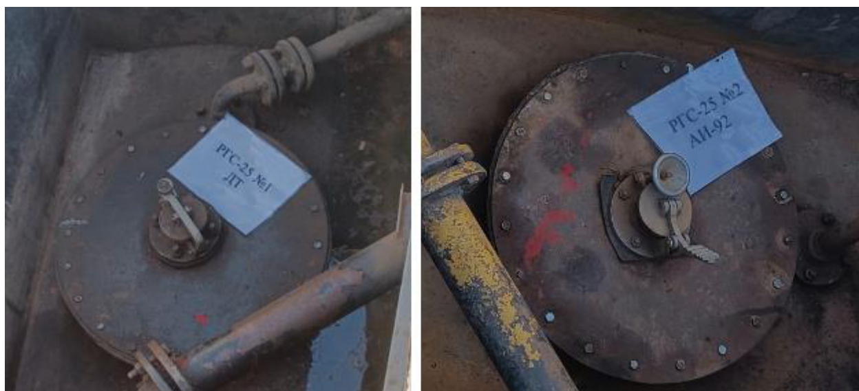
Рисунок 3 – Горловины резервуаров РГС-25 зав.№№ 1, 2
