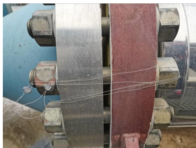
Рисунок 1б и 1в – Схема пломбировки трансмиттера и фланцев УЗР
