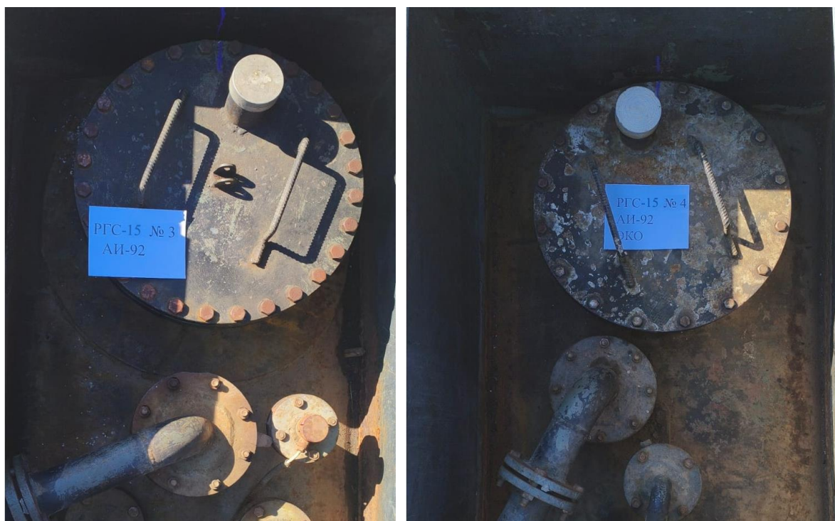
Рисунок 3 – Горловины резервуаров РГС-15 зав.№№ 3, 4
