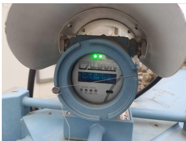
Рисунок 1б и 1в – Схема пломбировки трансмиттера и фланцев УЗР
