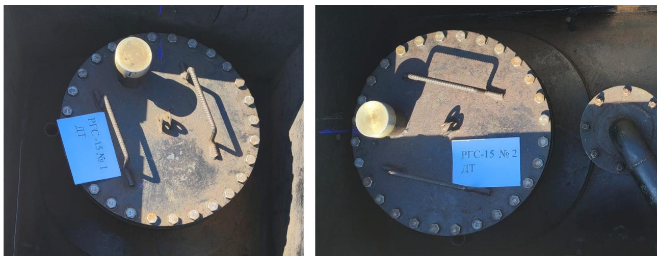
Рисунок 2 – Горловины резервуаров РГС-15 зав.№№ 1, 2
