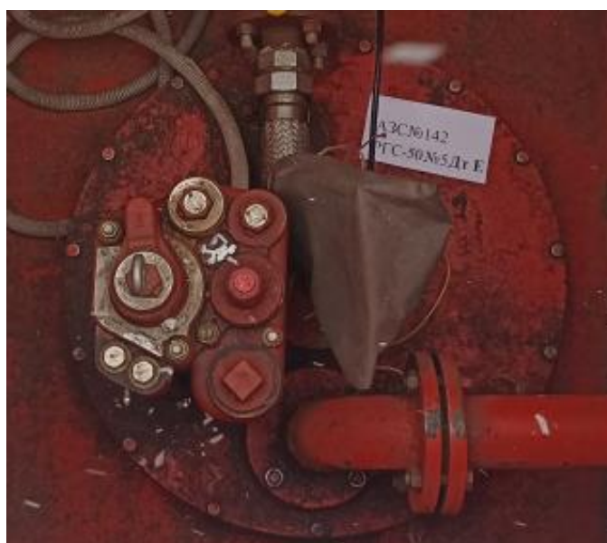
Рисунок 4 – Горловина резервуара РГС-50 зав.№ 5
