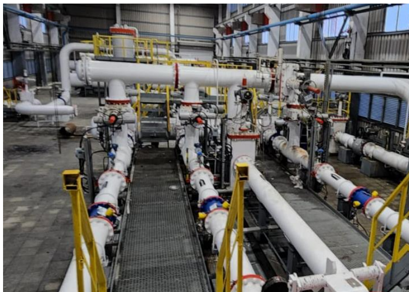
Рисунок 1 – Общий вид СИКН
