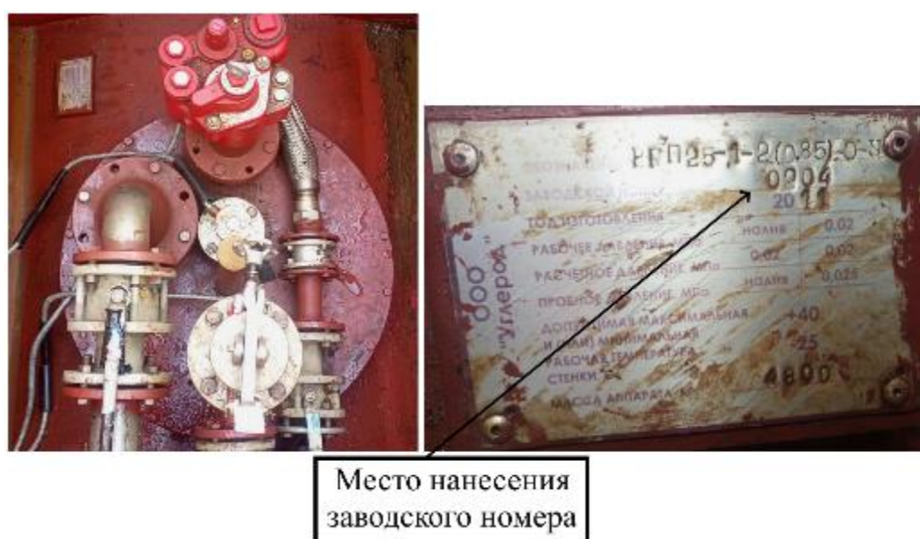
Рисунок 3 – Горловина и измерительный люк резервуара РГП 25-1-2(0,85)-О-У зав.№ 0204
