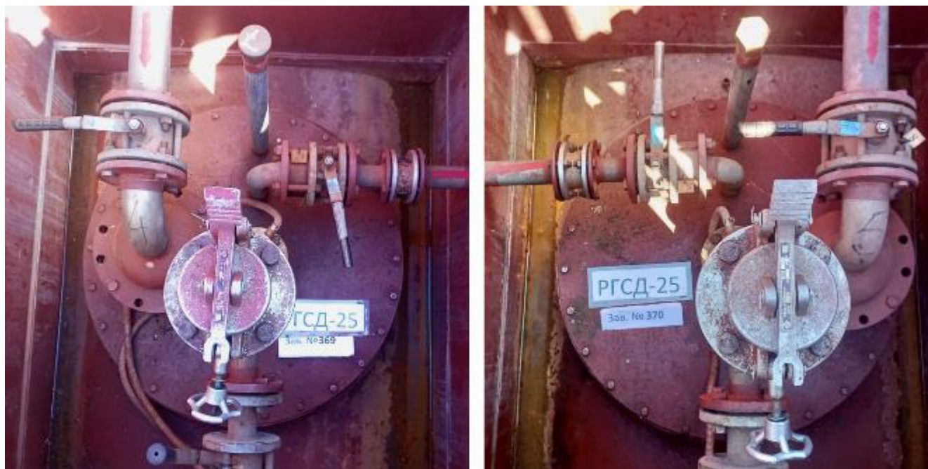
Рисунок 2 – Горловины и измерительные люки резервуаров РГСД-25 зав.№№ 369, 370
