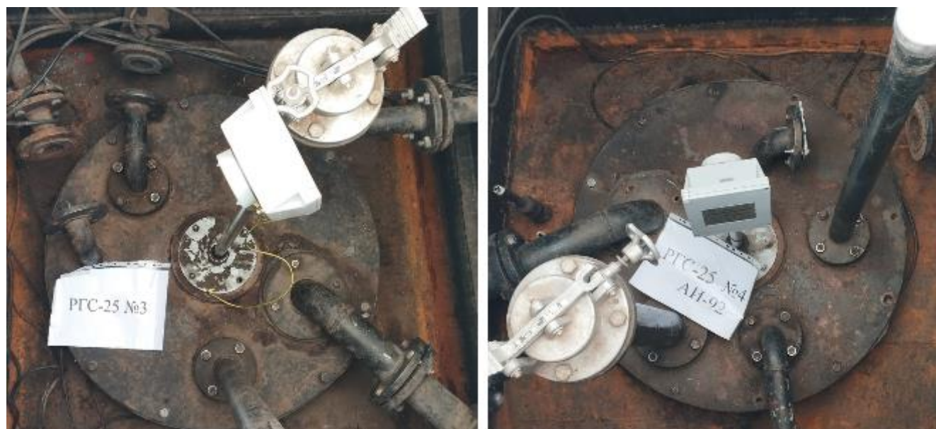
Рисунок 3 – Горловины резервуаров РГС-25 зав.№№ 3, 4
