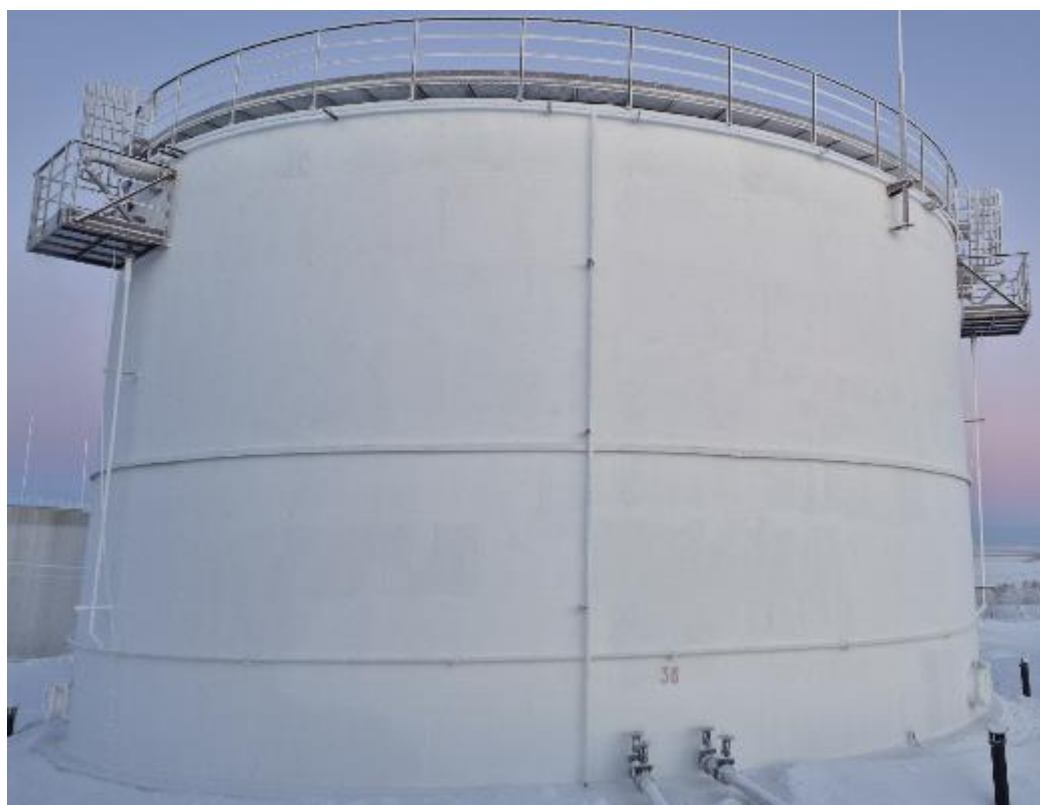
Рисунок 4 – Общий вид резервуара РВС-5000 зав.№ 38
