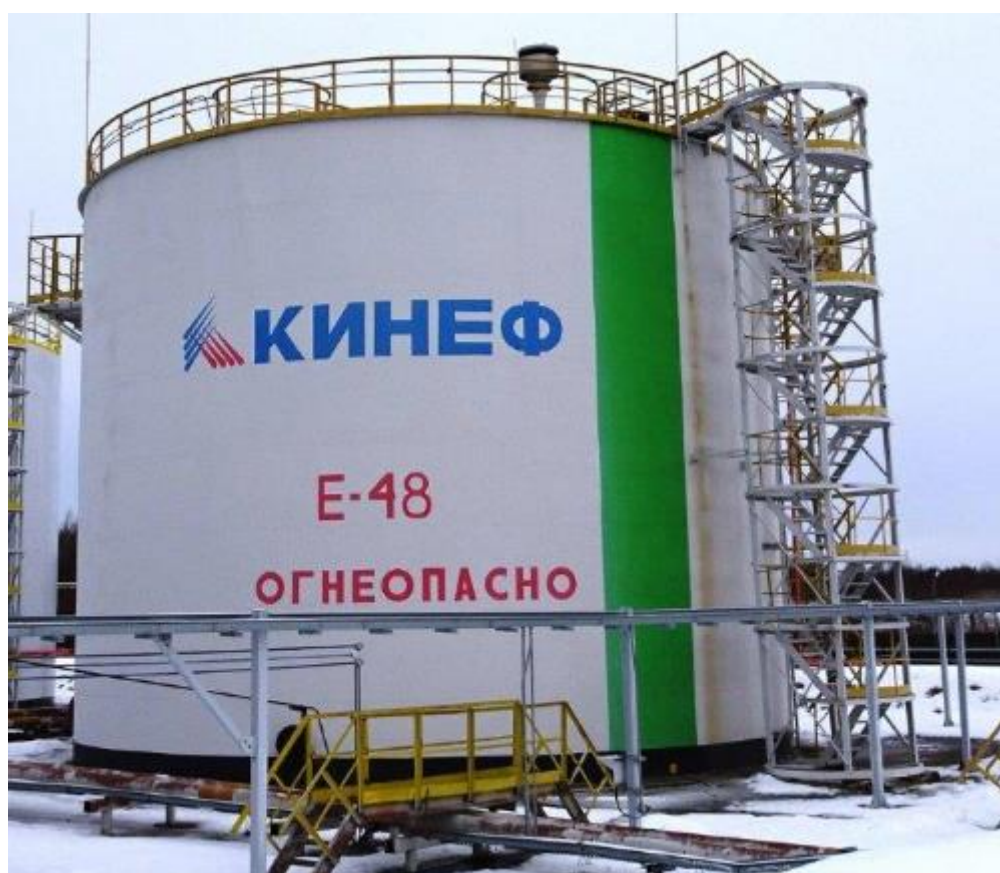
Рисунок 2 – Общий вид резервуара РВС-2000 зав.№ Е-48
