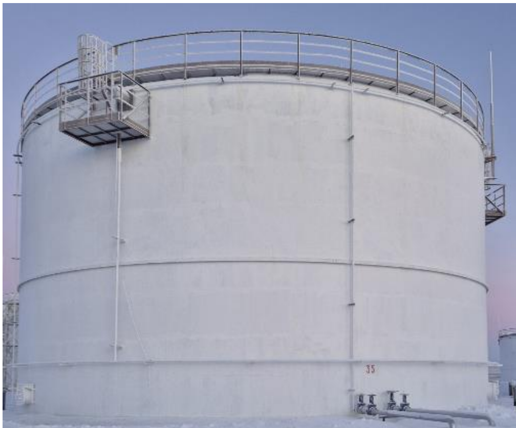
Рисунок 1 – Общий вид резервуара РВС-5000 зав.№ 35
