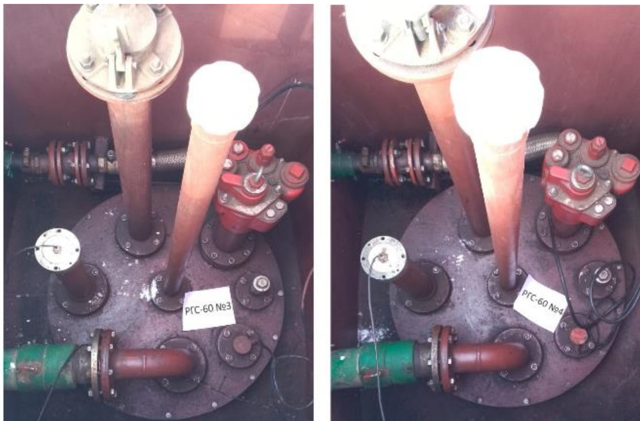
Рисунок 3 – Горловины резервуаров РГС-60 зав.№№ 3, 4
