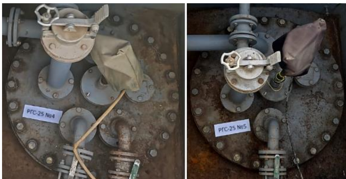
Рисунок 3 – Горловины резервуаров РГС-25 зав.№№ 4, 5
