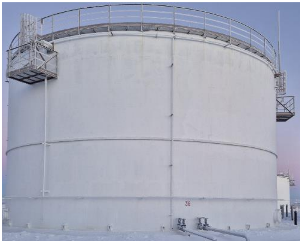
Рисунок 2 – Общий вид резервуара РВС-5000 зав.№ 36
