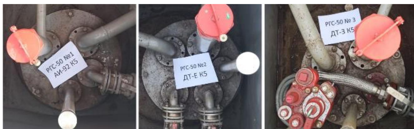
Рисунок 3 – Горловины резервуаров РГС-50 зав.№№ 1, 2, 3
