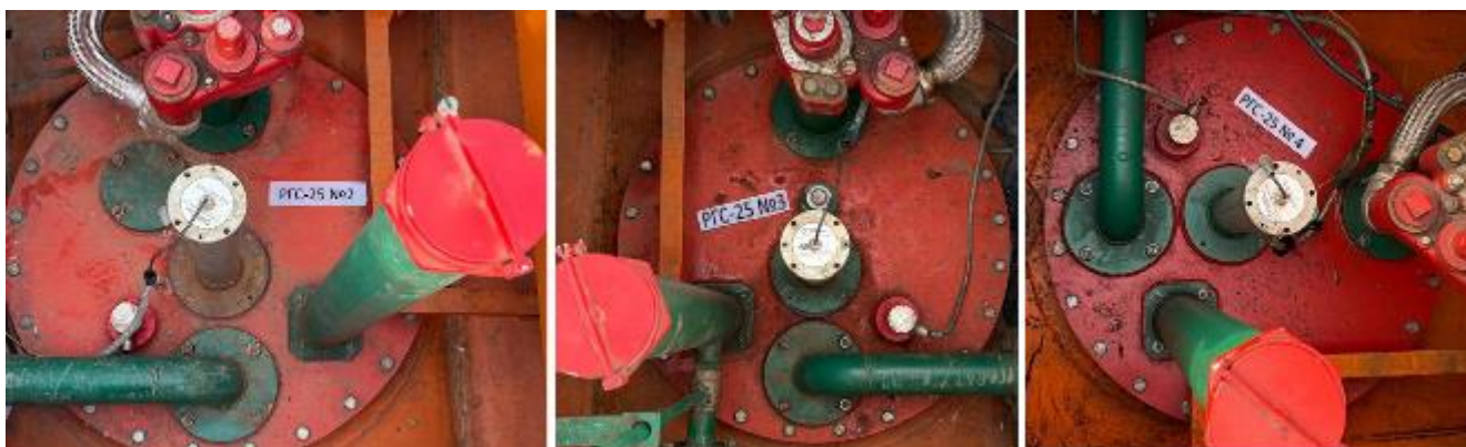
Рисунок 2 – Горловины резервуаров РГС-25 зав.№№ 2, 3, 4
