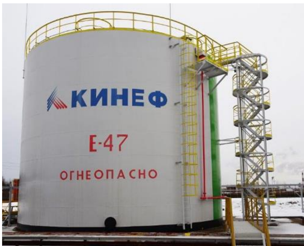
Рисунок 1 – Общий вид резервуара РВС-2000 зав.№ Е-47
