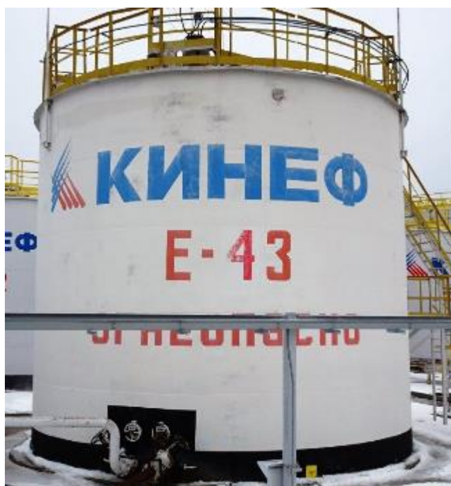
Рисунок 3 – Общий вид резервуара РВСП-400 зав.№ Е-43
