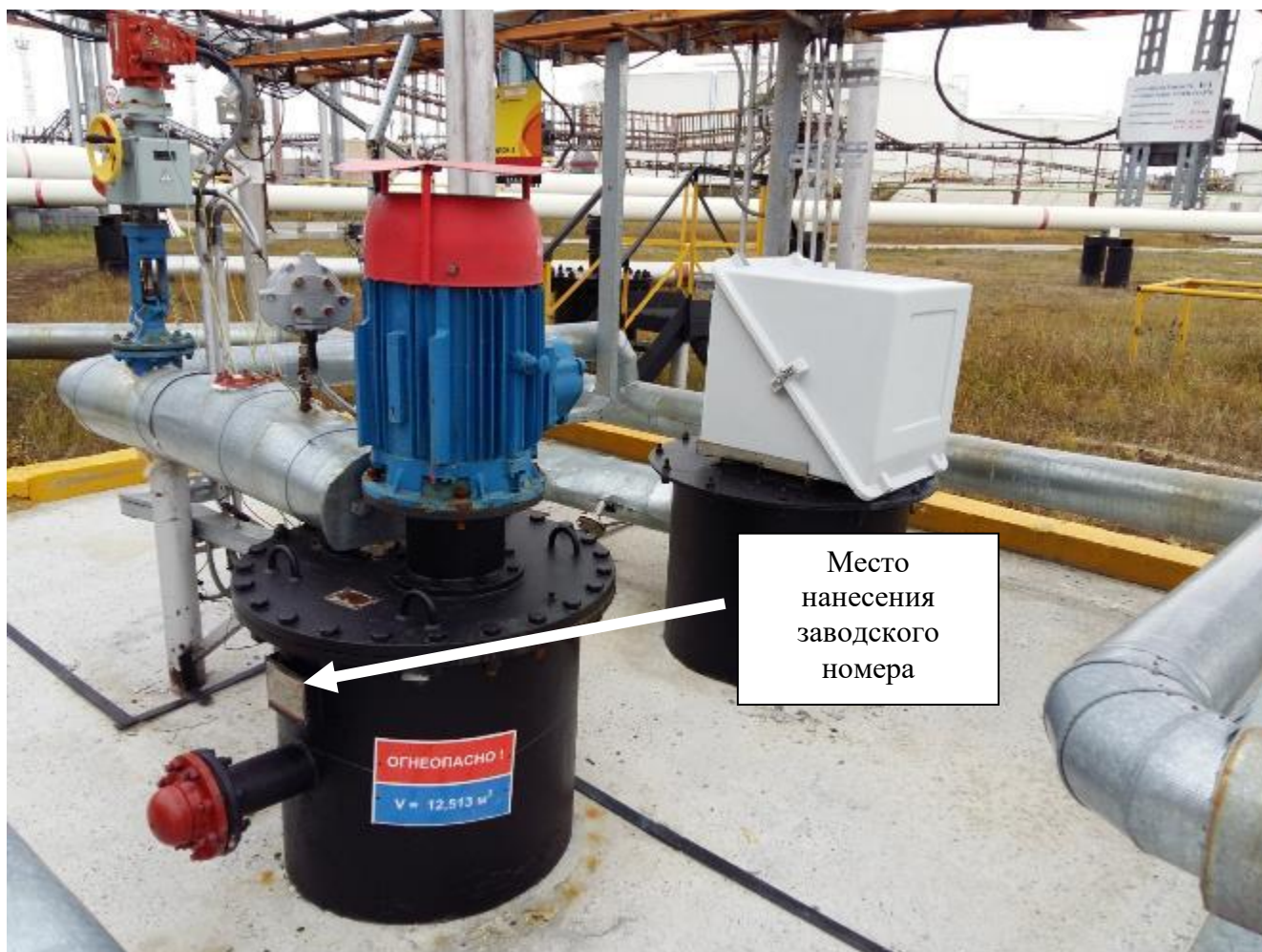
Рисунок 1 – РГС на месте эксплуатации
