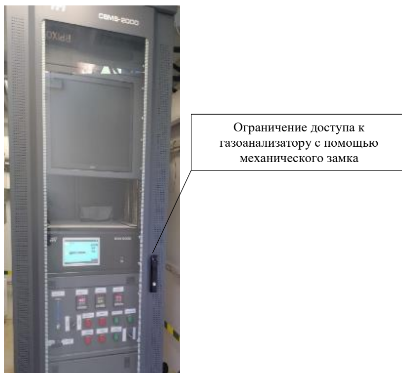
Рисунок 1 – Общий вид шкафа с газоанализатором дымовых газов ОМА-2000
