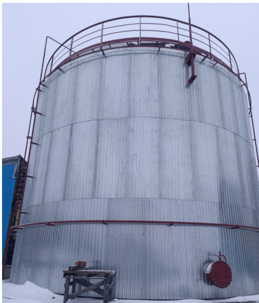
Рисунок 2 – Общий вид резервуара РВС-1000 с зав.№ 140
