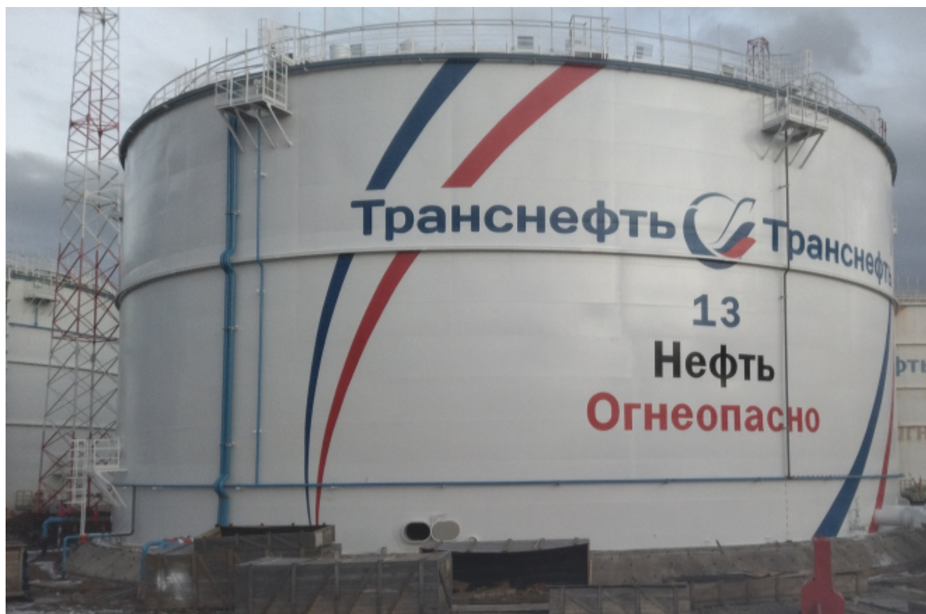
Рисунок 1 – Общий вид резервуара РВСП-20000 № 13
