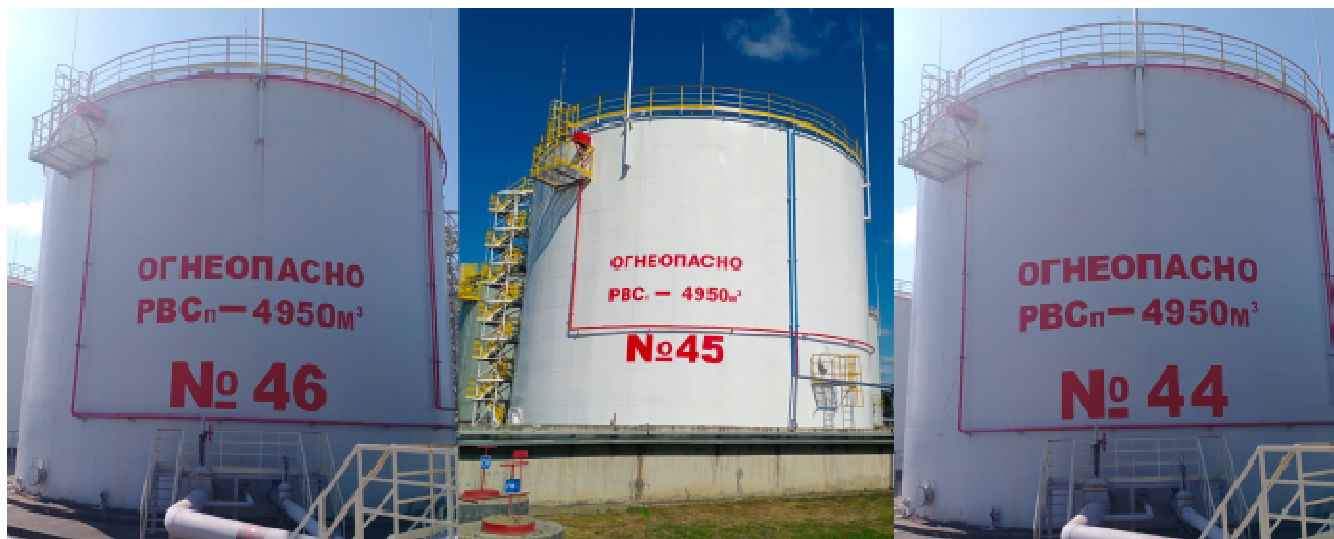
Рисунок 1 – общий вид резервуаров стальных вертикальных цилиндрических с понтонем РВСп-4950, заводские №№ 44, 45, 46
