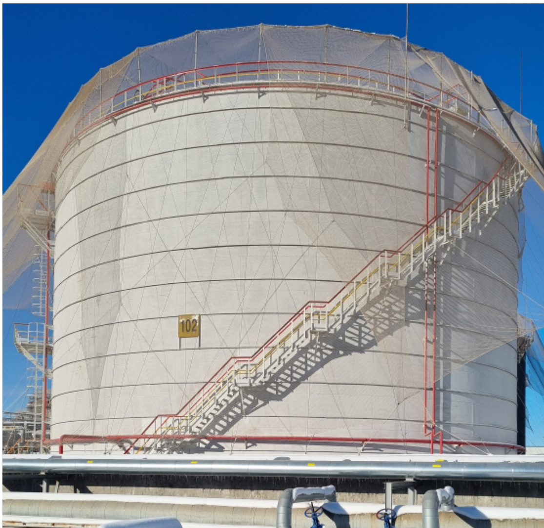
Рисунок 2 – Общий вид резервуара РВС-10000 зав.№ 102
