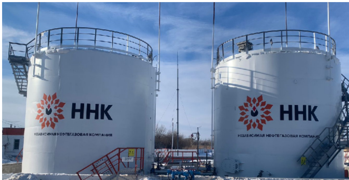
Рисунок 1 – Общий вид резервуаров вертикальных стальных цилиндрических РВС-400 зав.№№ 12, 14
