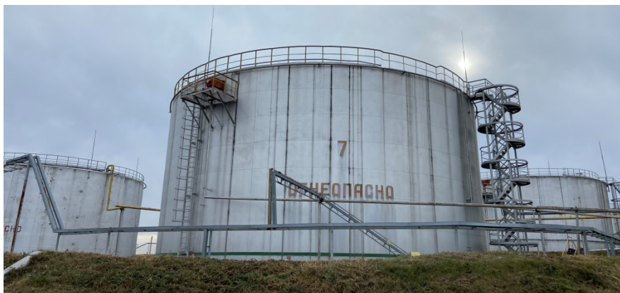
Рисунок 1 – Общий вид резервуаров
