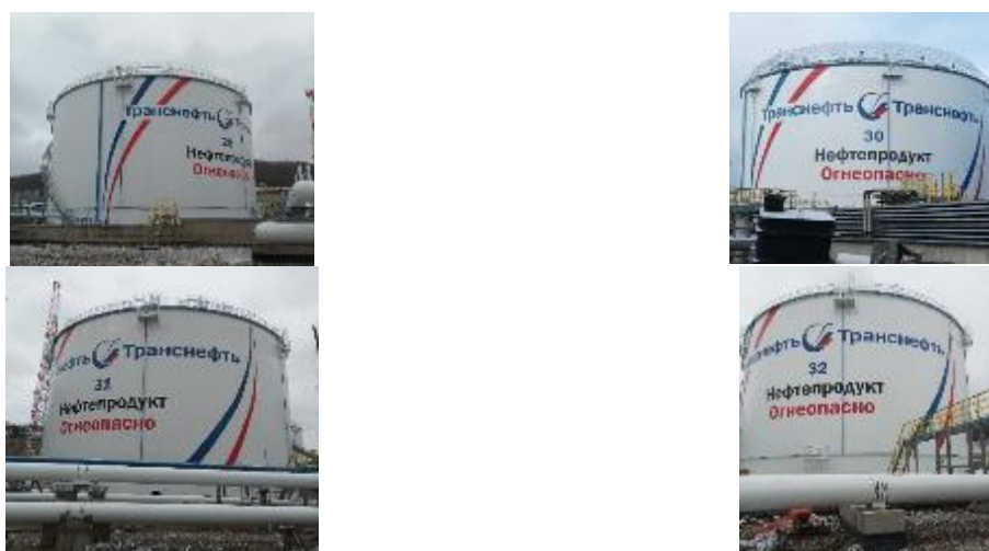
Рисунок 1 – Общий вид резервуаров РВСП-30000
