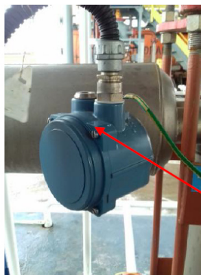
Схема пломбировки преобразователя счетчика-расходомера массового
