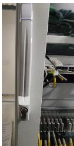
Рисунок 17 – Устройство запираения стойки СПС1
