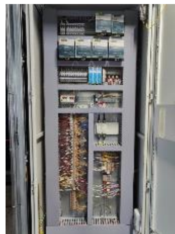
Рисунок 4 – Шкаф кроссовый измерений ШКИ
