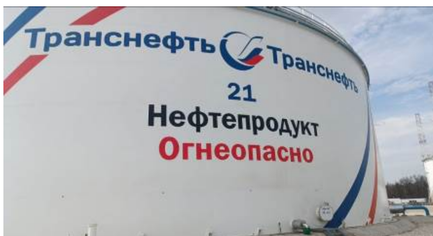
Рисунок 1 – Общий вид резервуара РВС-20000
