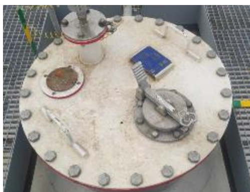
Рисунок 2 – Внешний вид эксплуатационной горловины резервуара
