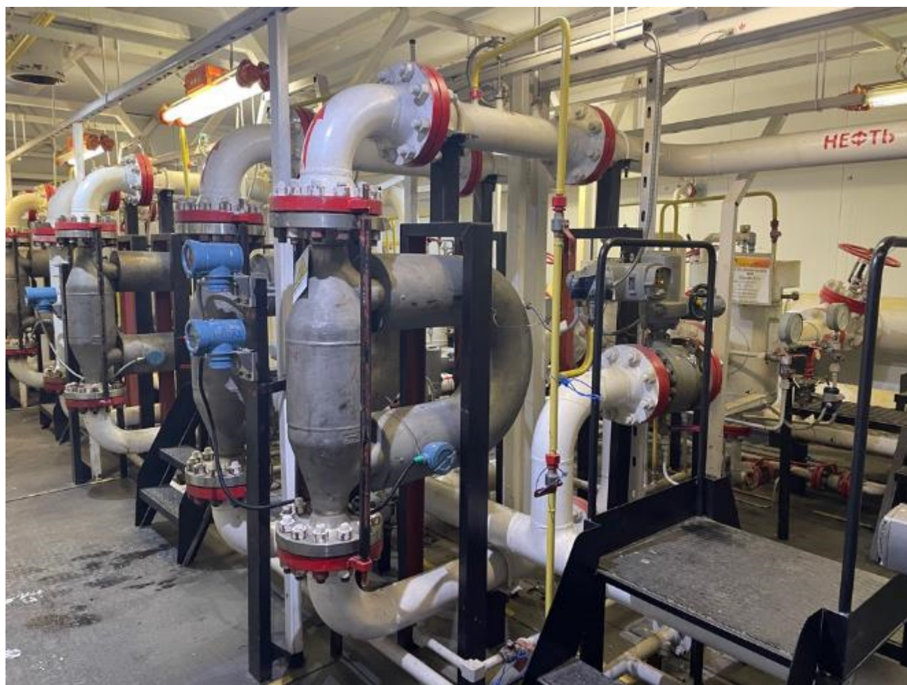
Рисунок 1 – Общий вид СИКНС
