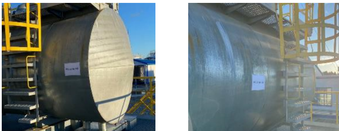
Рисунок 2 – Места нанесения заводских номеров резервуаров РГС-20
