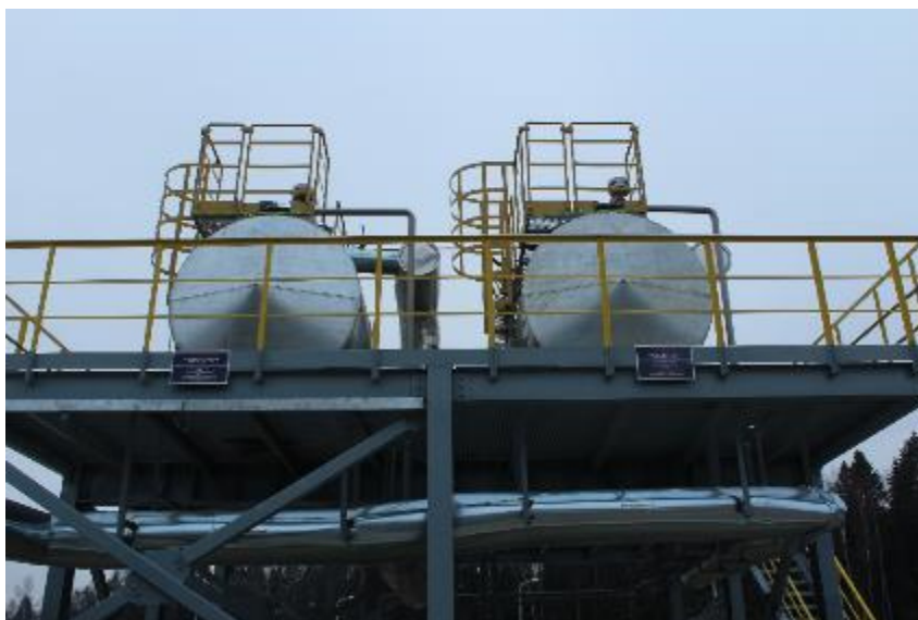
Рисунок 1 – Общий вид резервуаров РГС-20
