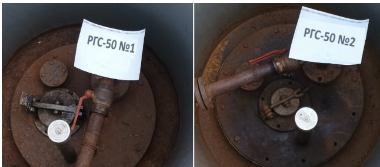
Рисунок 2 – Горловины резервуаров РГС-50 зав.№№ 1, 2
