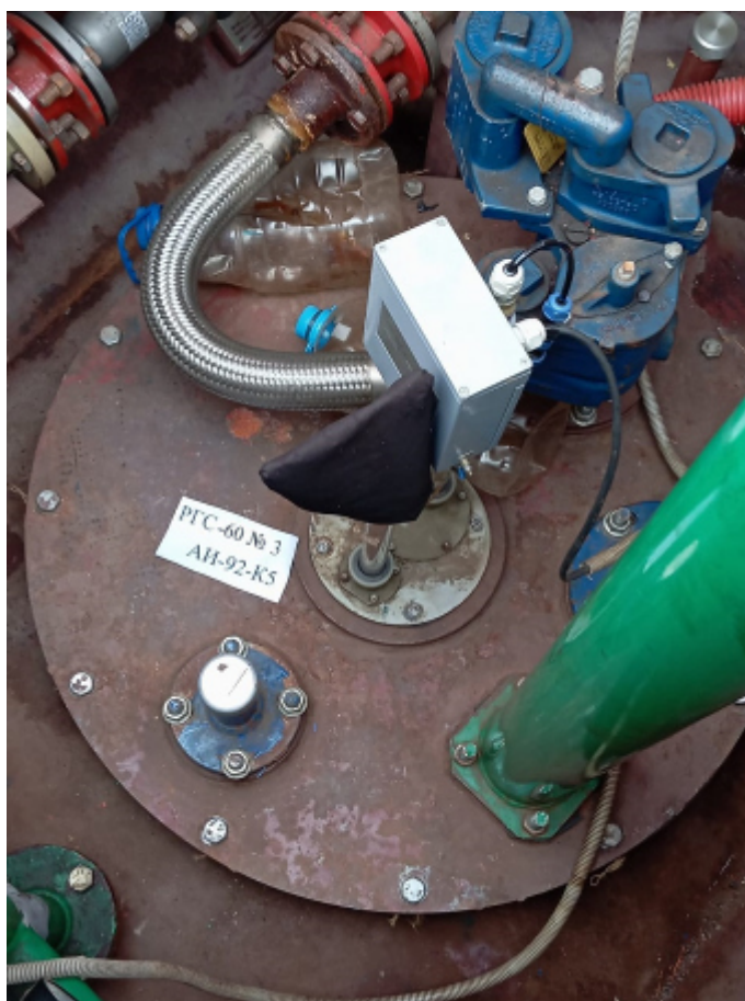
Рисунок 3 – Горловина резервуара РГС-60 зав.№ 3
