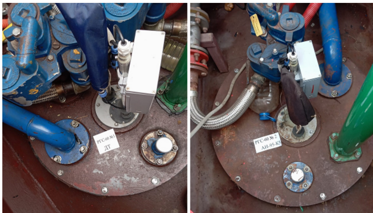
Рисунок 2 – Горловины резервуаров РГС-60 зав.№№ 1, 2
