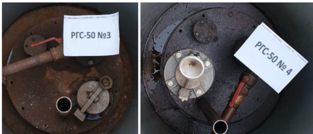
Рисунок 3 – Горловины резервуаров РГС-50 зав.№№ 3, 4
