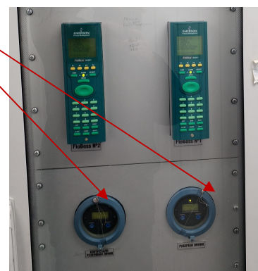
Рисунок 2 – Места нанесения заводского номера, знака поверки и места установки пломб
