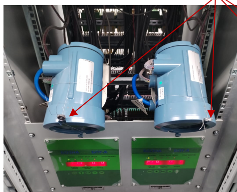
Рисунок 2 – Места нанесения заводского номера, знака поверки и места установки пломб
