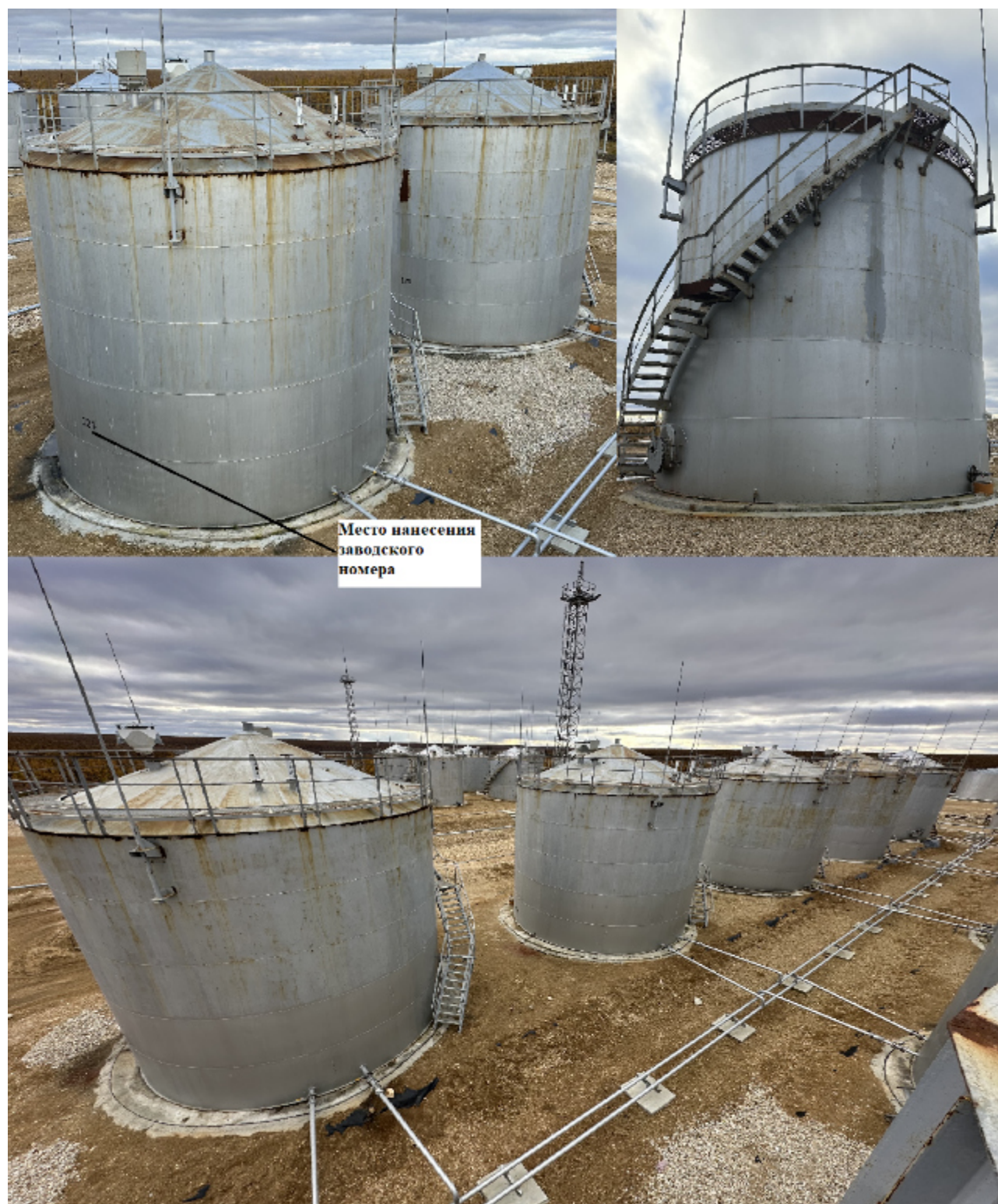
Рисунок 2 – Общий вид резервуаров вертикальных стальных цилиндрических РВС-400, зав.№№ 1.2.1, 1.2.4, 1.2.5, 1.2.6, 1.2.7, 1.2.8, 1.2.9 с указанием места нанесения заводских номеров
