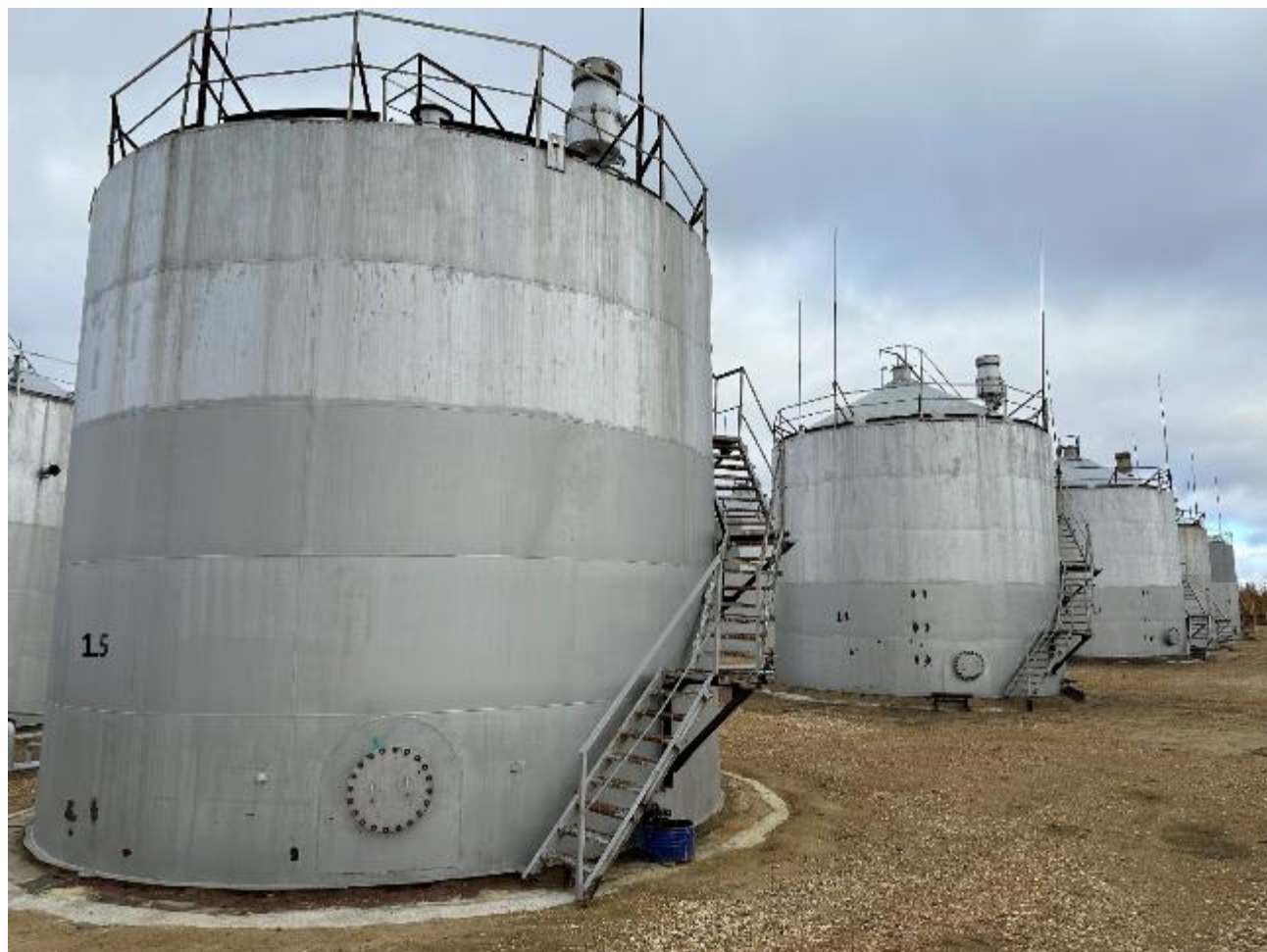
Рисунок 1 – Общий вид резервуаров вертикальных стальных цилиндрических РВС-400 зав.№№ 1.3, 1.4, 1.5 с указанием места нанесения заводских номеров
