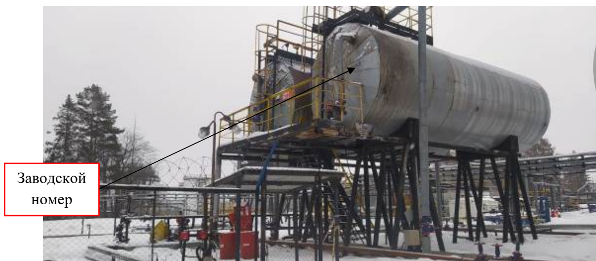
Рисунок 1 – Общий вид резервуара горизонтального стального цилиндрического РГС-75, заводской номер 5 с указанием места нанесения заводского номера
