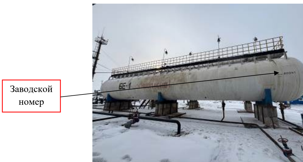
Рисунок 1 – Общий вид резервуара горизонтального стального цилиндрического РГС-180, заводской номер 20061 с указанием места нанесения заводского номера
