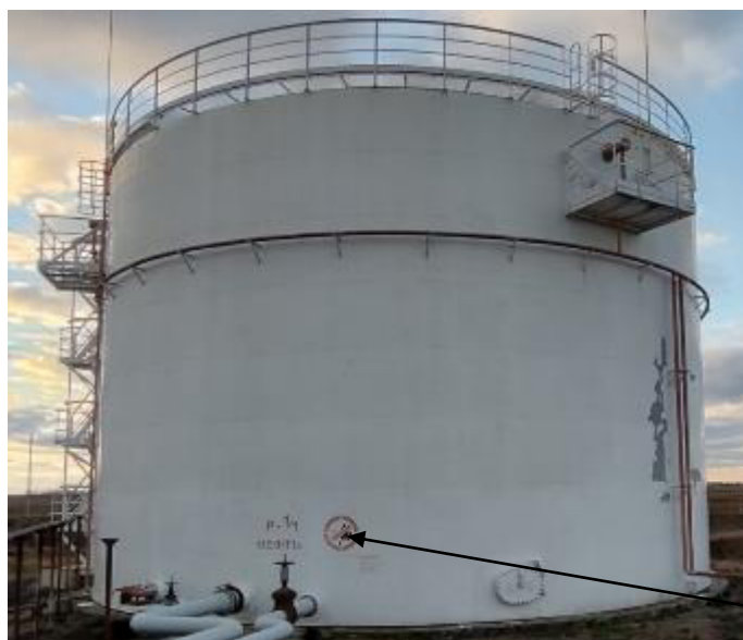
Рисунок 1 – Общий вид резервуара РВС-3000, зав. № Р-1/1, замерного люка и места нанесения заводского номера
