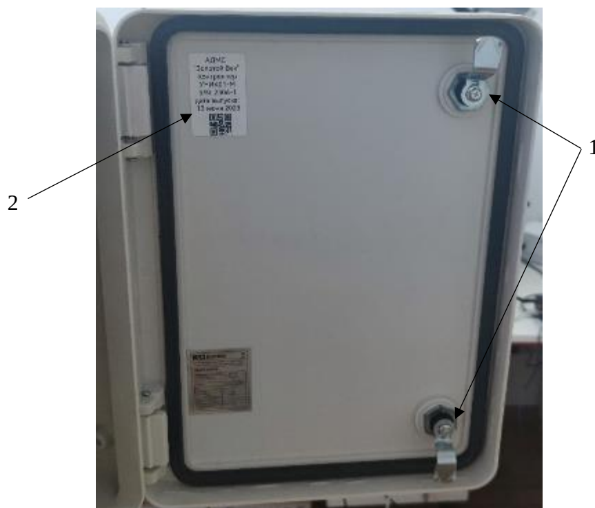
1 – замки на корпусе телеметрического шкафа станции Золотой Век; 2 – место нанесения заводского номера.
