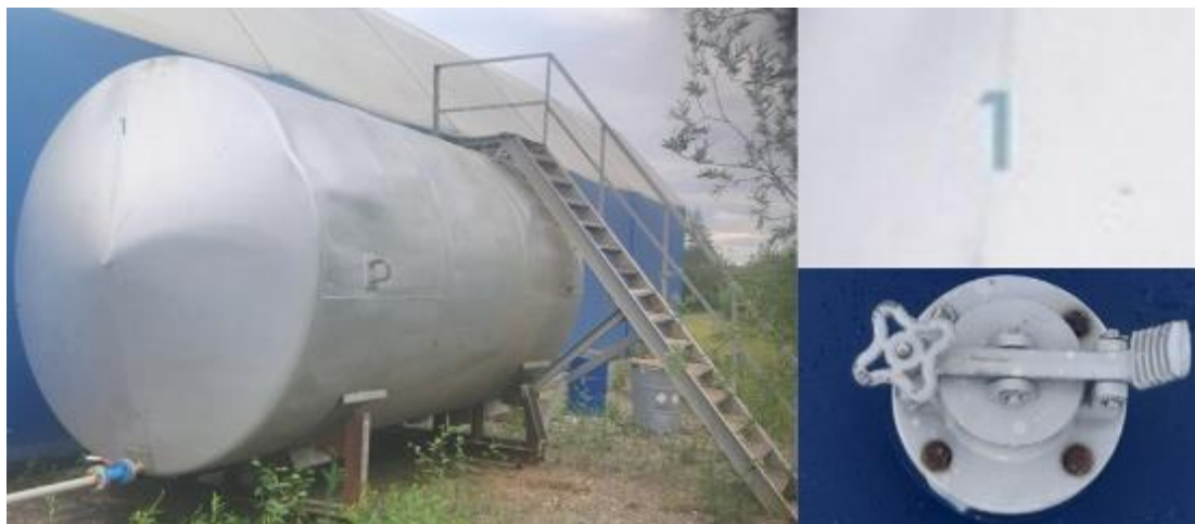
Рисунок 1 – Фотография общего вида резервуара РГС-25, горловины и заводского номера
