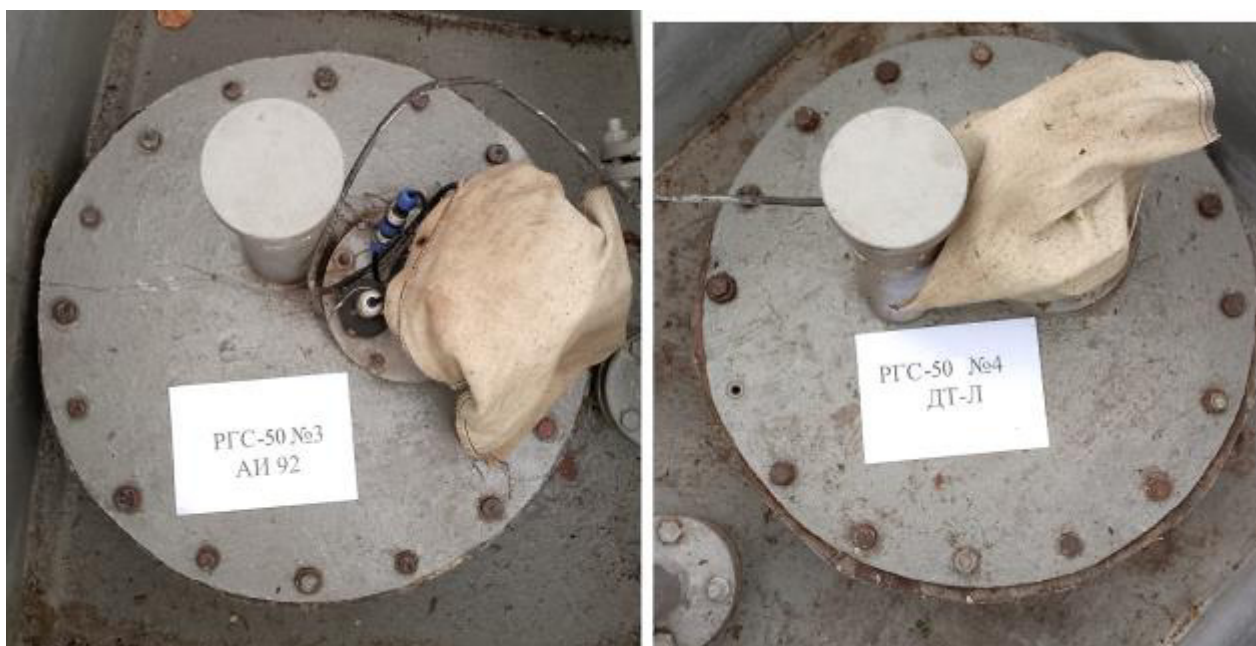
Рисунок 3 – Горловины резервуаров РГС-50 зав.№№ 3, 4
