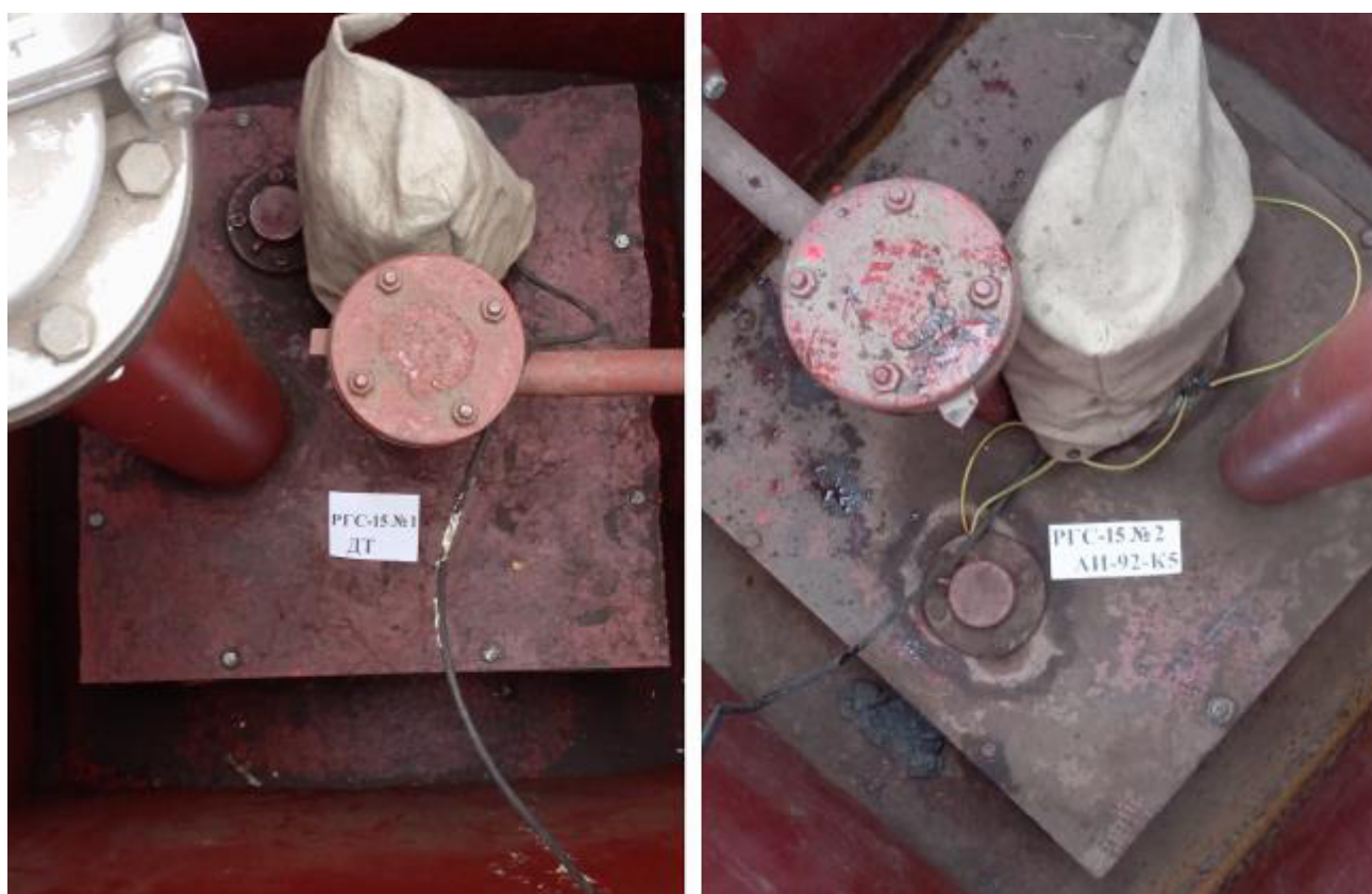
Рисунок 2 – Горловины резервуаров РГС-15 зав.№№ 1, 2
