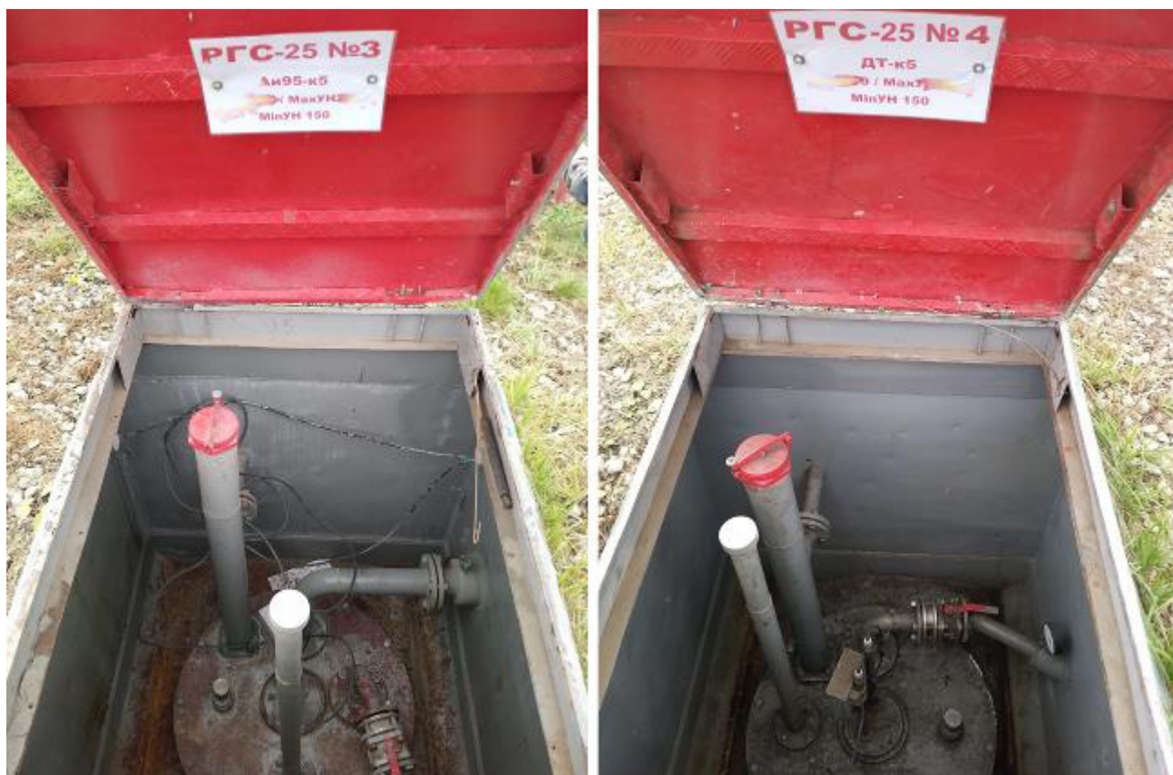
Рисунок 3 – Горловины резервуаров РГС-25 зав.№№ 3, 4
