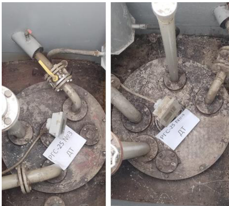
Рисунок 2 – Горловины резервуаров РГС-25 зав.№№ 3, 4
