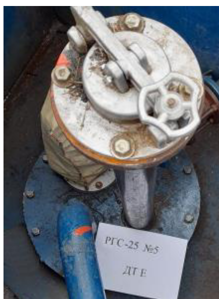
Рисунок 4 – Горловина резервуара РГС-25 зав.№ 5
