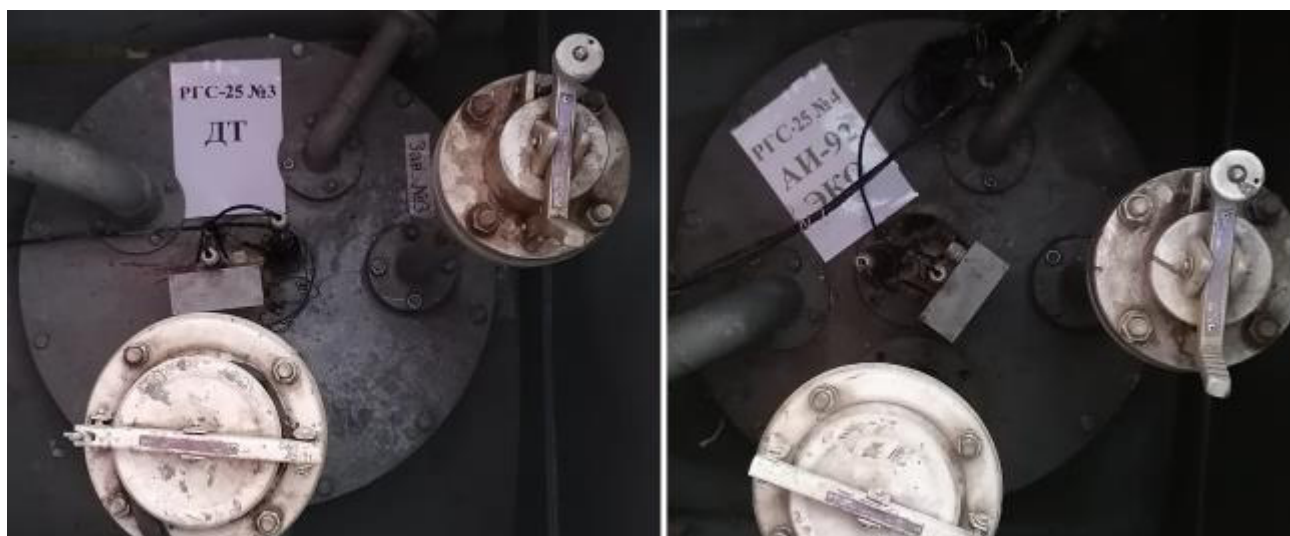
Рисунок 3 – Горловины резервуаров РГС-25 зав.№№ 3, 4
