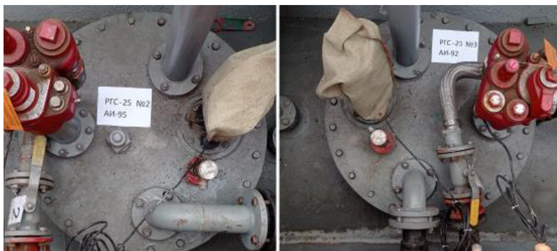
Рисунок 2 – Горловины резервуаров РГС-25 зав.№№ 2, 3
