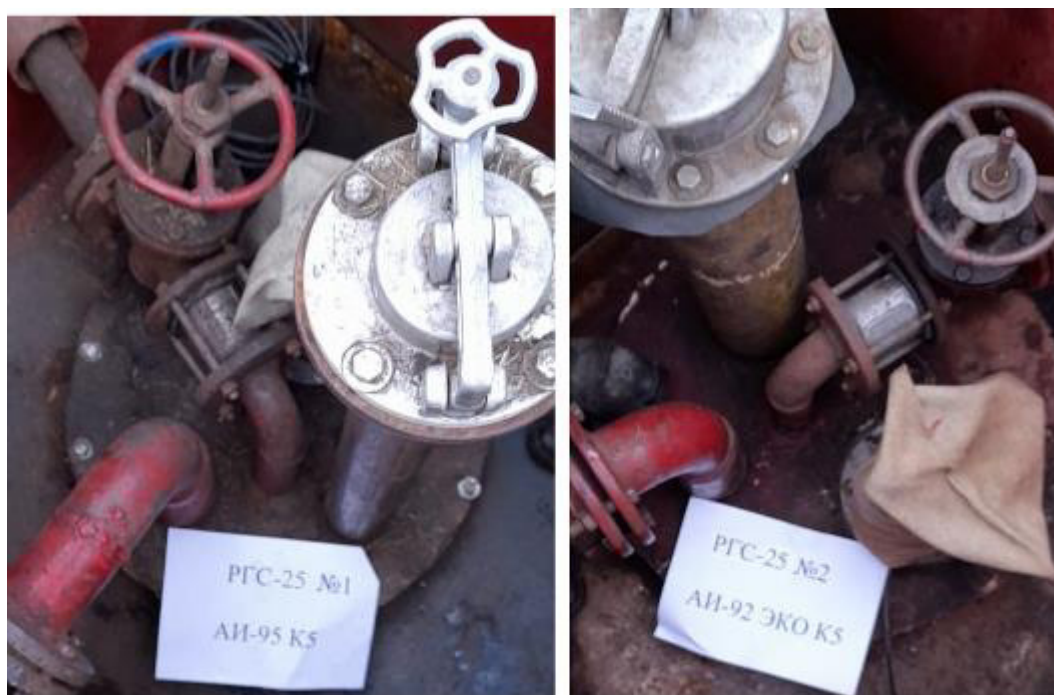
Рисунок 2 – Горловины резервуаров РГС-25 зав.№№ 1, 2
