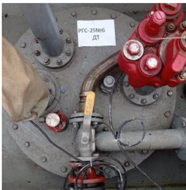
Рисунок 4 – Горловина резервуара РГС-25 зав.№ 6
