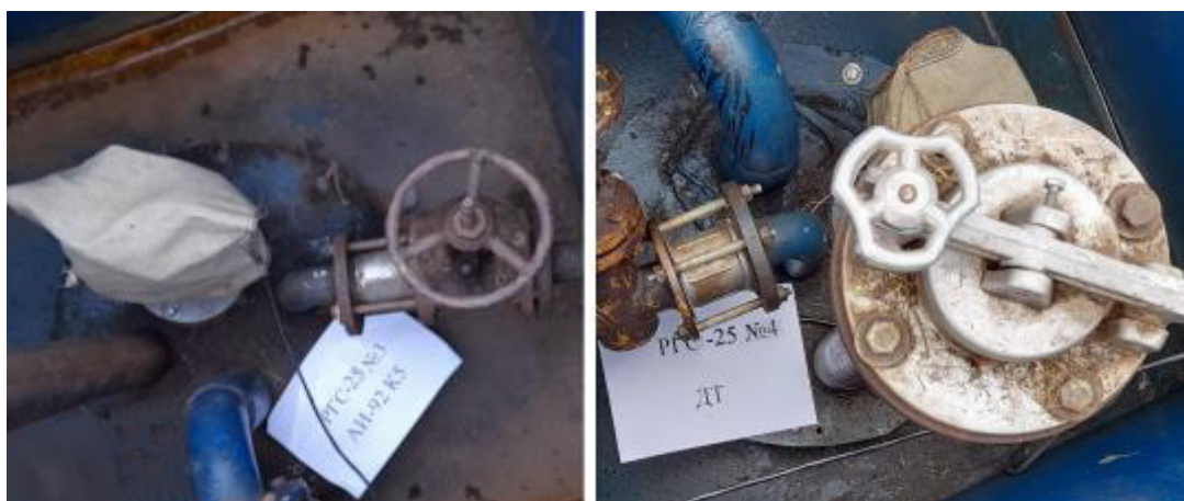
Рисунок 3 – Горловины резервуаров РГС-25 зав.№№ 3, 4
