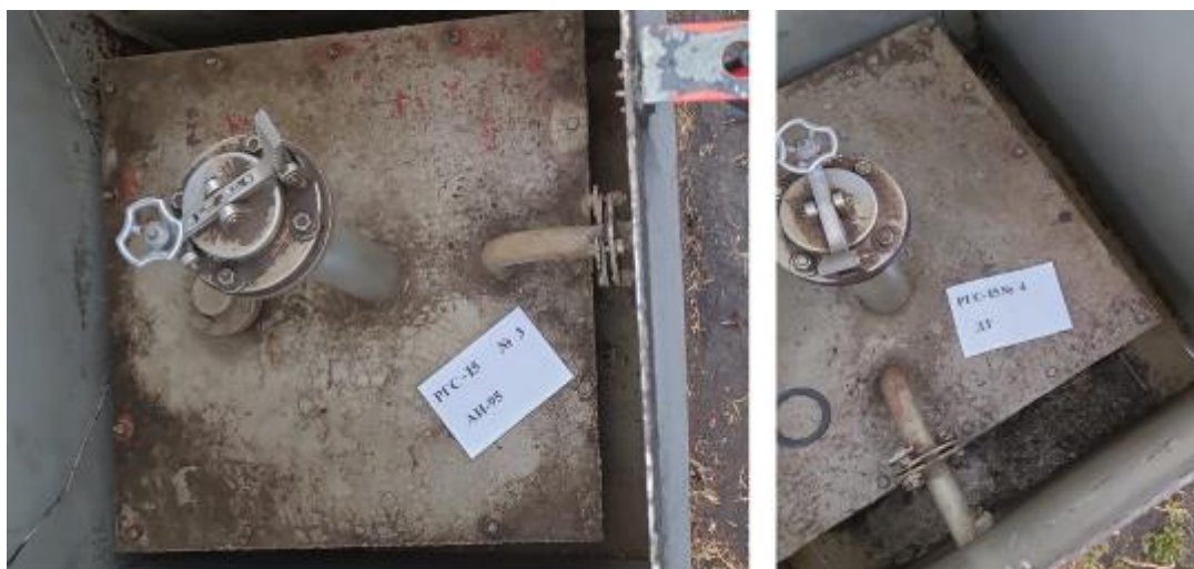
Рисунок 2 – Горловины резервуаров РГС-15 зав.№№ 3, 4
