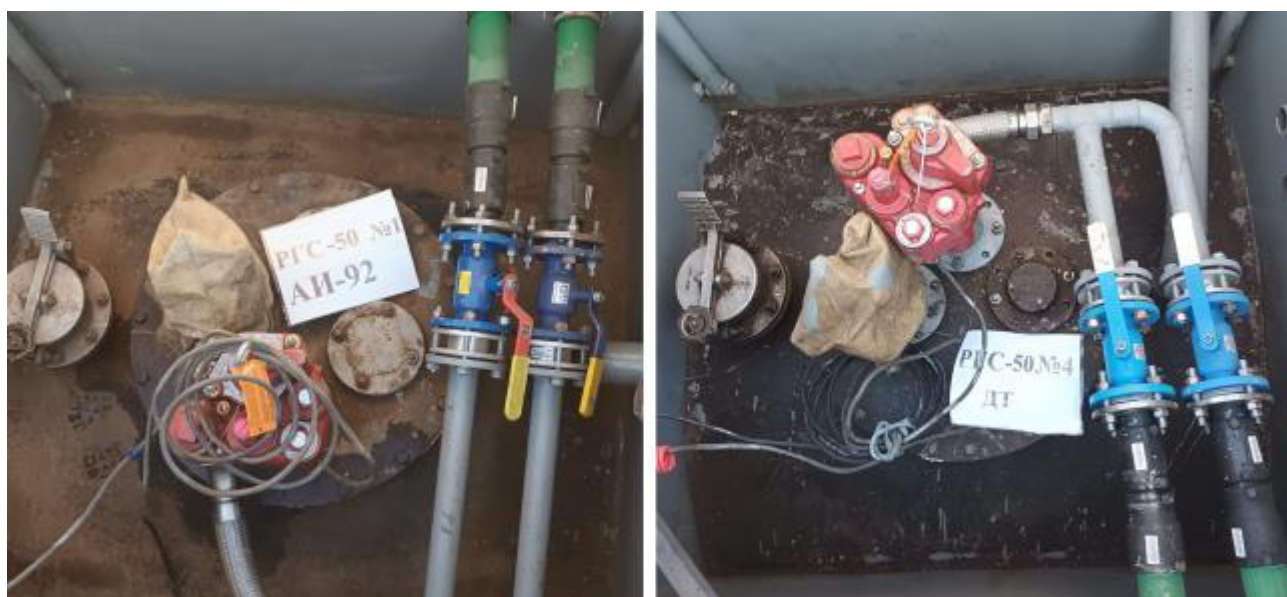
Рисунок 4 – Горловины резервуаров РГС-50 зав.№№ 1, 4
