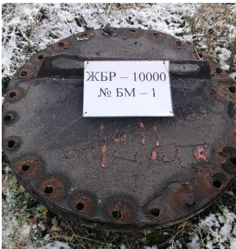
Рисунок 2 – Горловина резервуара ЖБР-10000 № БМ-1
