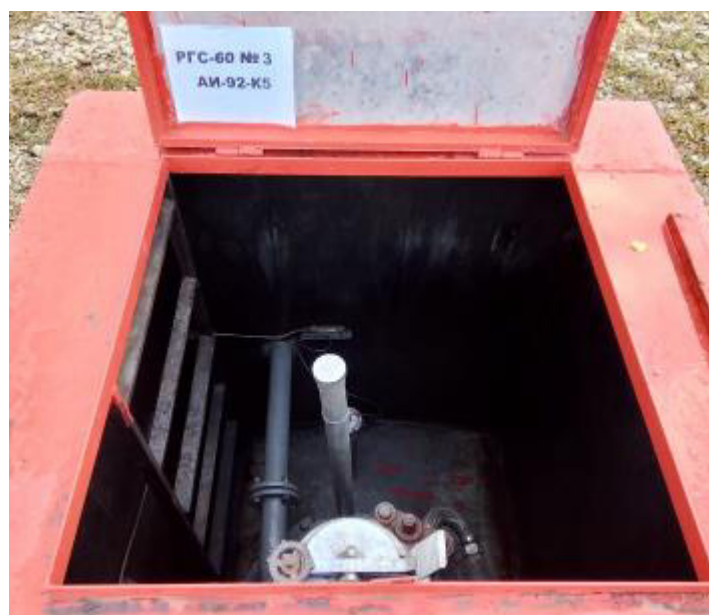
Рисунок 4 – Горловина резервуара РГС-60 зав.№ 3
