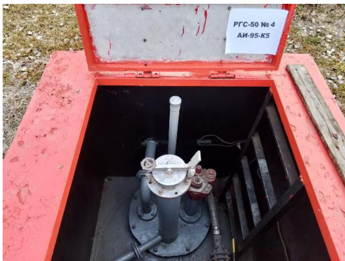
Рисунок 2 – Горловина резервуара РГС-50 зав.№ 4
