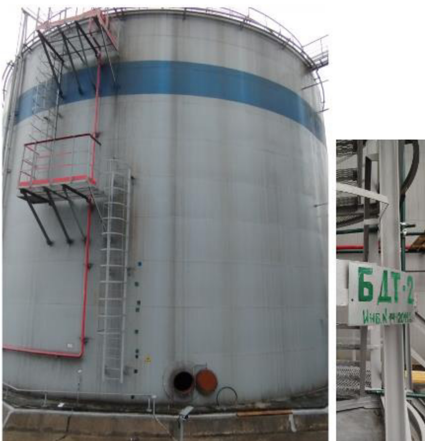
Рисунок 2 – Общий вид резервуара РВС-5000 зав.№ БДТ-2
