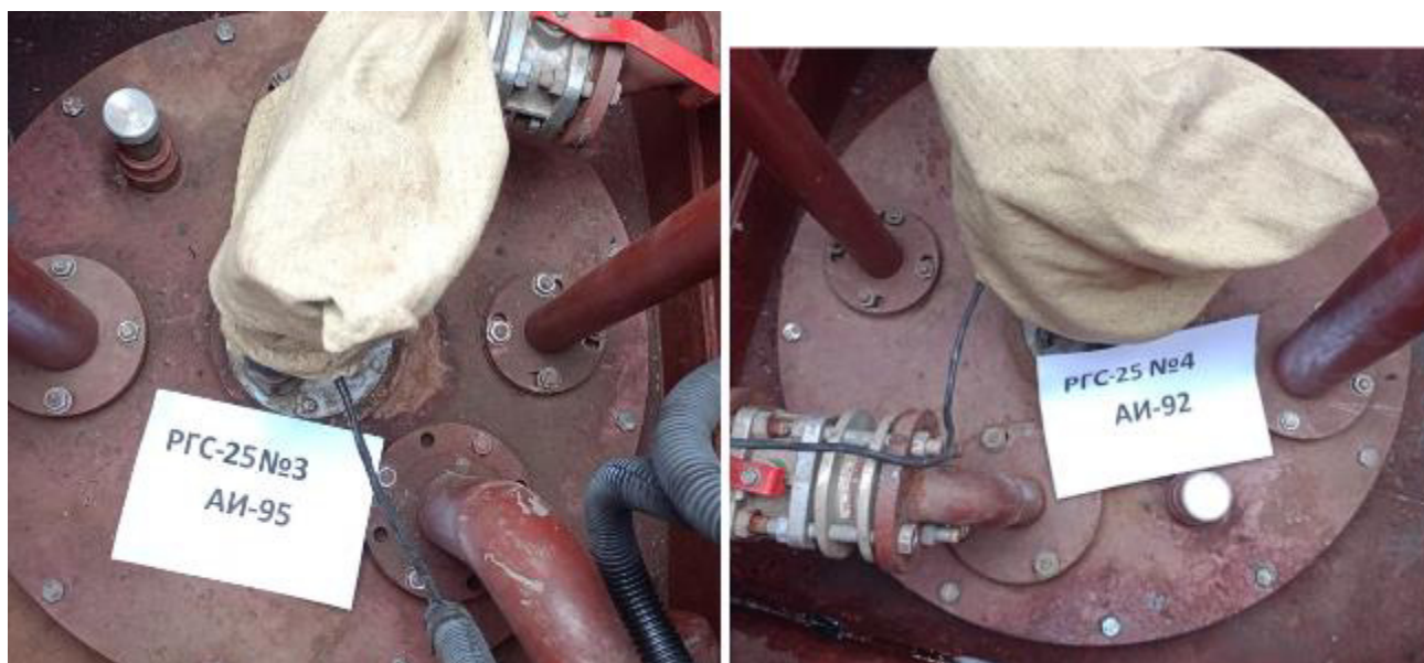
Рисунок 3 – Горловины резервуаров РГС-25 зав.№№ 3, 4
