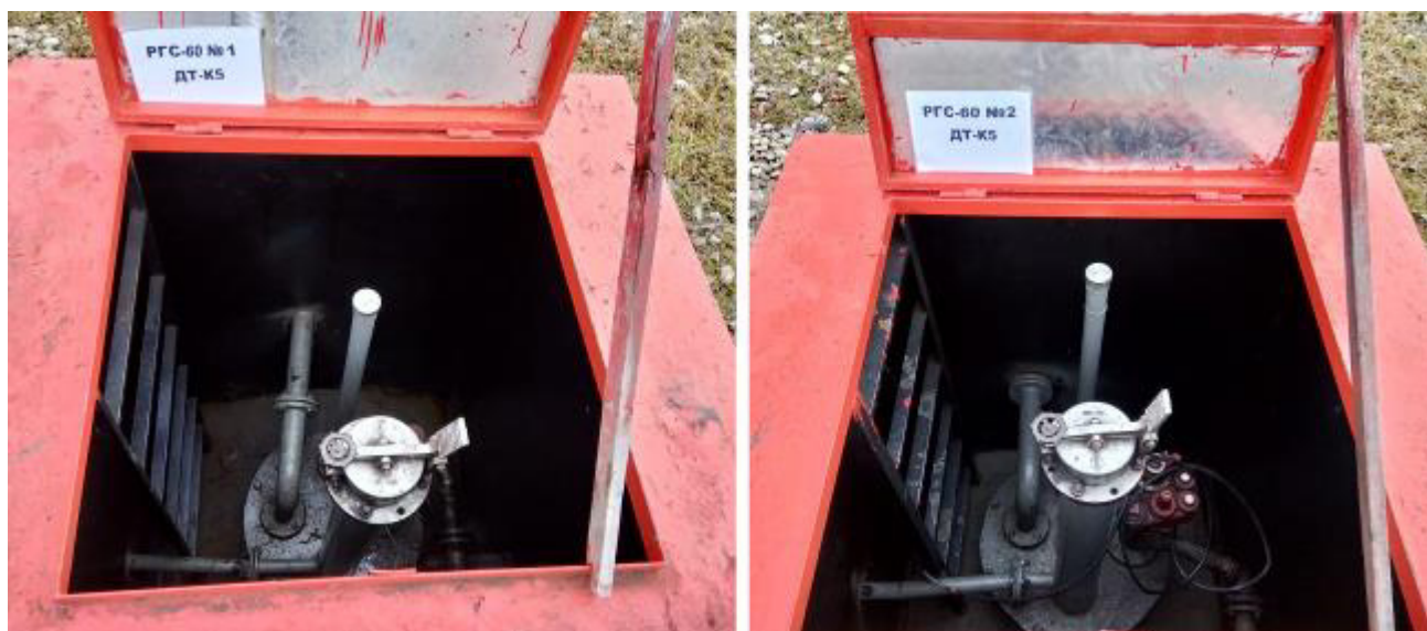
Рисунок 3 – Горловины резервуаров РГС-60 зав.№№ 1, 2
