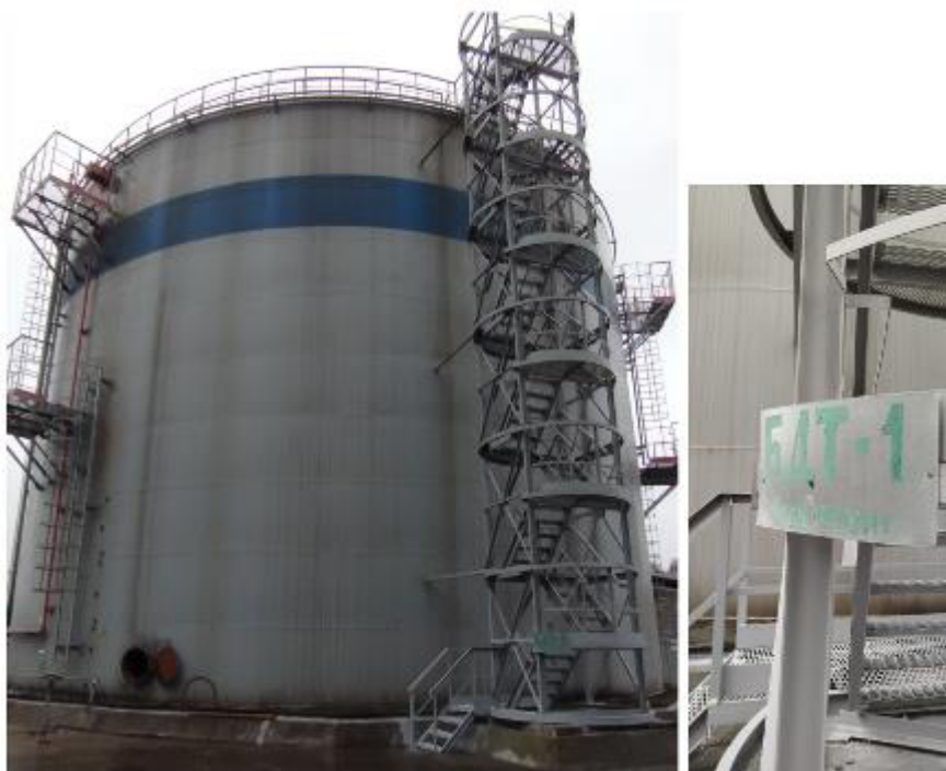
Рисунок 1 – Общий вид резервуара РВС-5000 зав.№ БДТ-1
