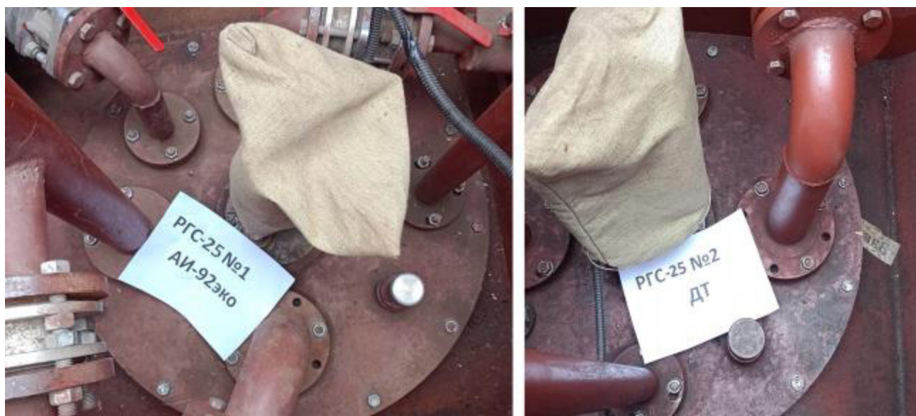
Рисунок 2 – Горловины резервуаров РГС-25 зав.№№ 1, 2
