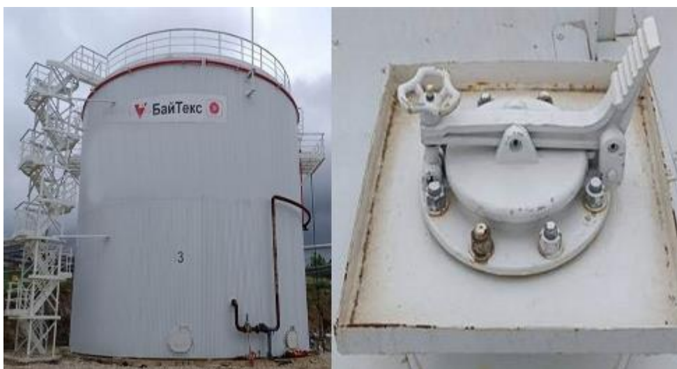
Рисунок 1 – Фотографии общего вида резервуара стального вертикального цилиндрического РВС-2000 (зав.№ 3), горловины замерного люка и заводского номера
