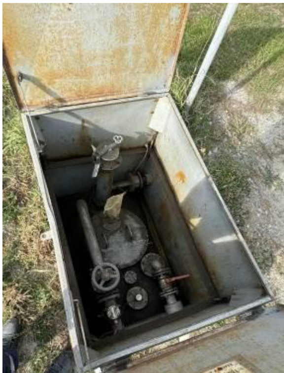
Р и с у н о к 4 – Фотография горловины и замерного люка резервуара
