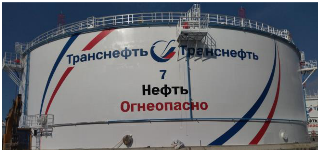
Рисунок 1 – Общий вид резервуара РВСП-20000 № 7
