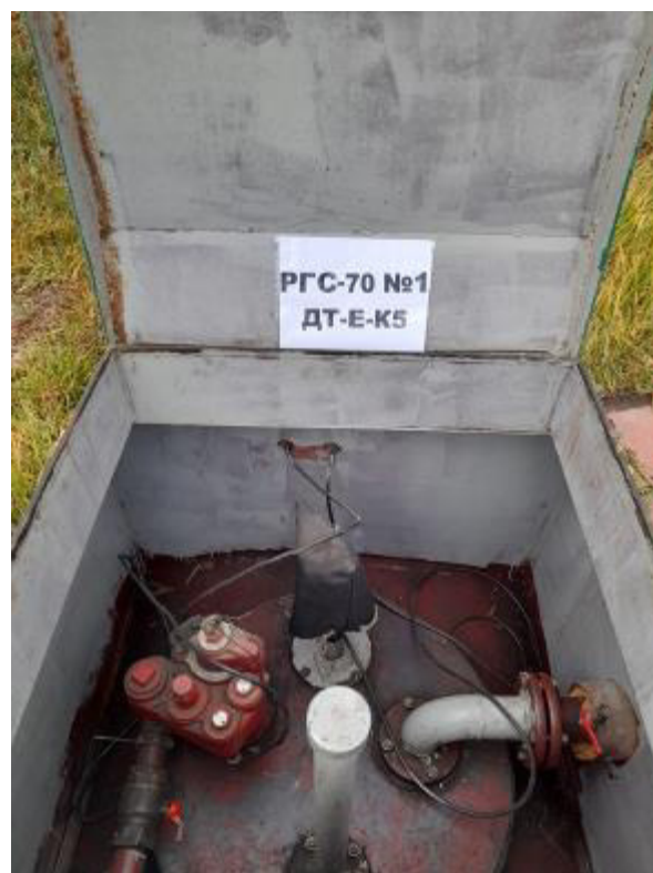
Рисунок 6 – Горловина резервуара РГС-70 зав.№ 1
