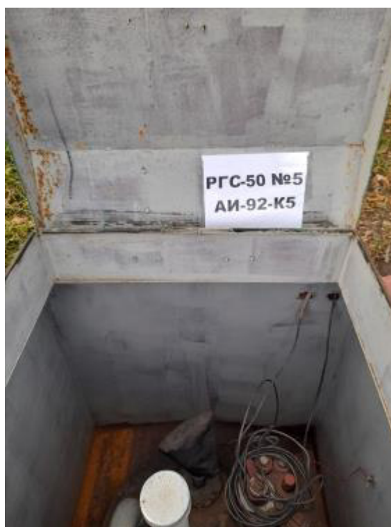
Рисунок 4 – Горловина резервуара РГС-50 зав.№ 5
