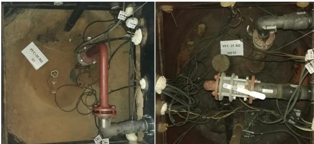
Рисунок 2 – Горловины резервуаров РТС-25 зав.№№ 1, 2
