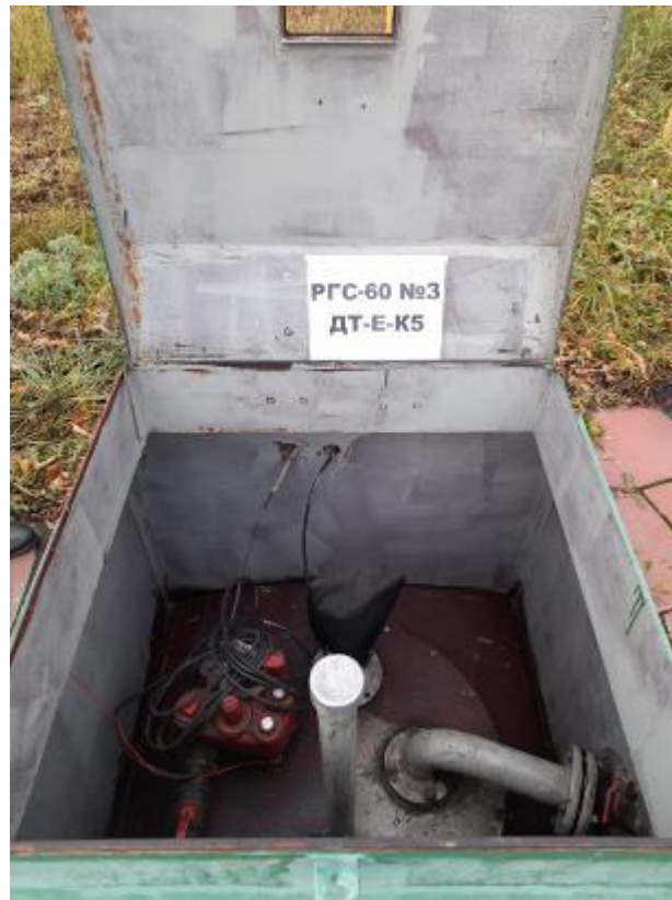
Рисунок 5 – Горловина резервуара РГС-60 зав.№ 3
