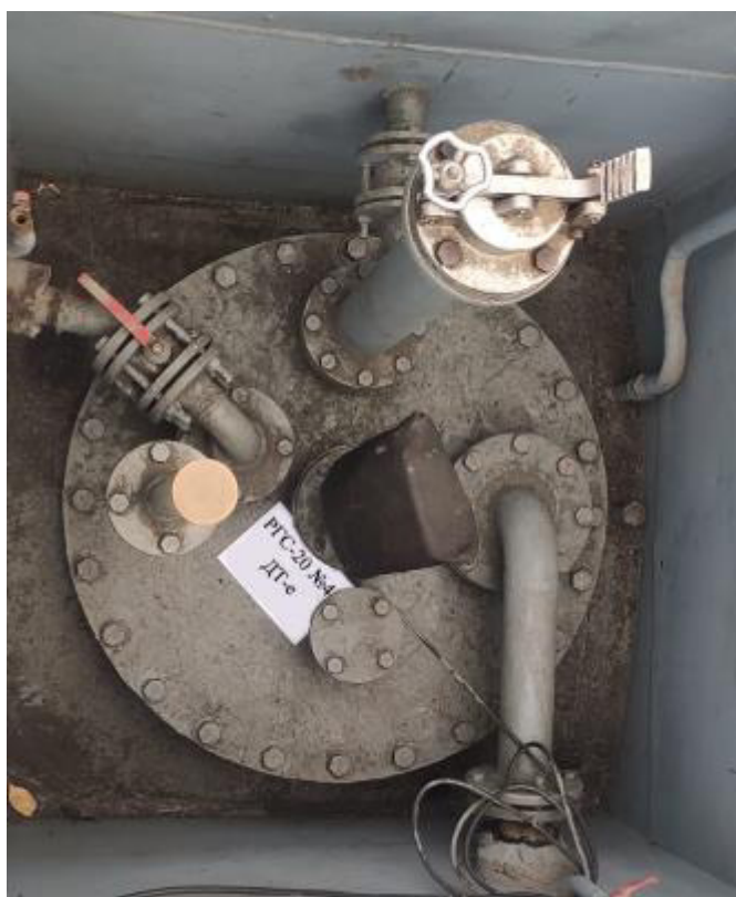
Рисунок 2 – Горловина резервуара РГС-20 зав.№ 4
