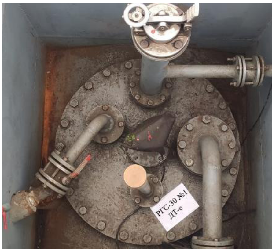
Рисунок 5 – Горловина резервуара РГС-30 зав.№ 1
