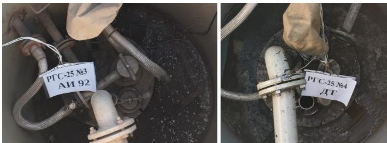
Рисунок 4 – Горловины резервуаров РГС-25 зав.№№ 3, 4
