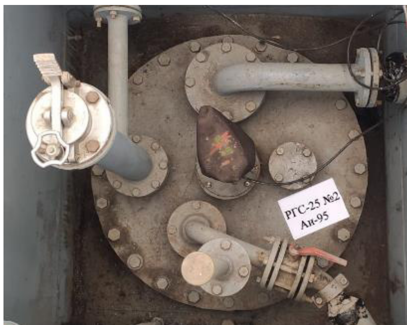
Рисунок 3 – Горловина резервуара РГС-25 зав.№ 2
