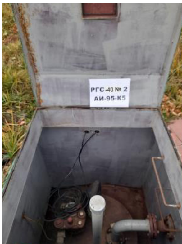
Рисунок 3 – Горловина резервуара РГС-40 зав.№ 2
