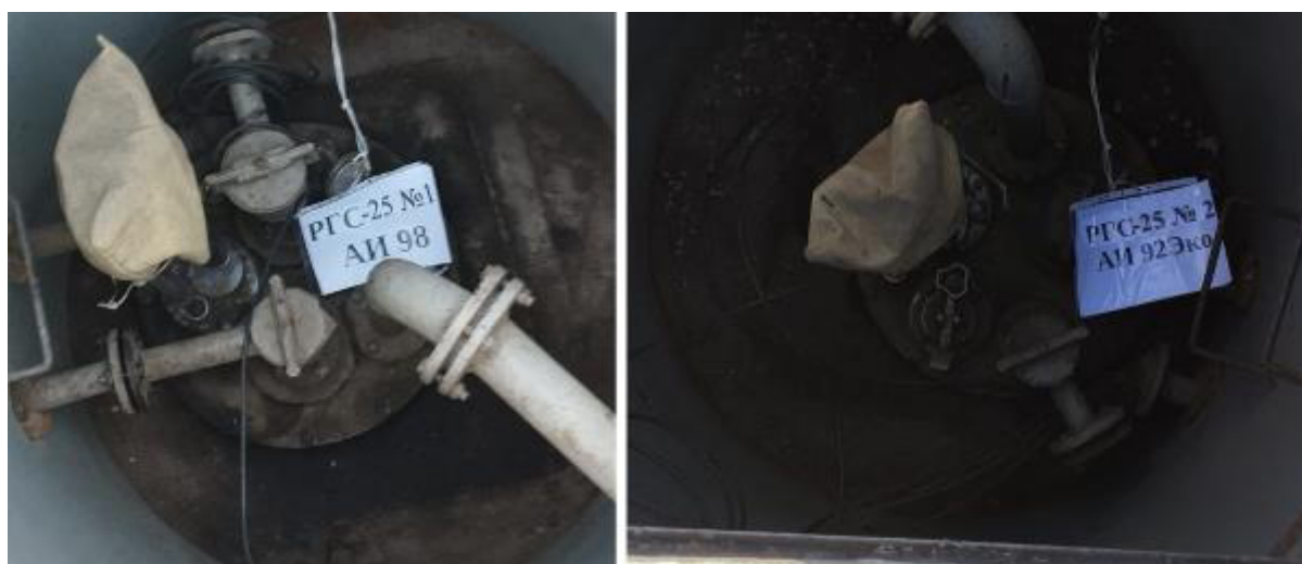
Рисунок 3 – Горловины резервуаров РГС-25 зав.№№ 1, 2
