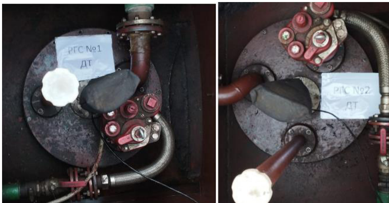
Рисунок 2 – Горловины резервуаров РГС-50 зав.№№ 1, 2
