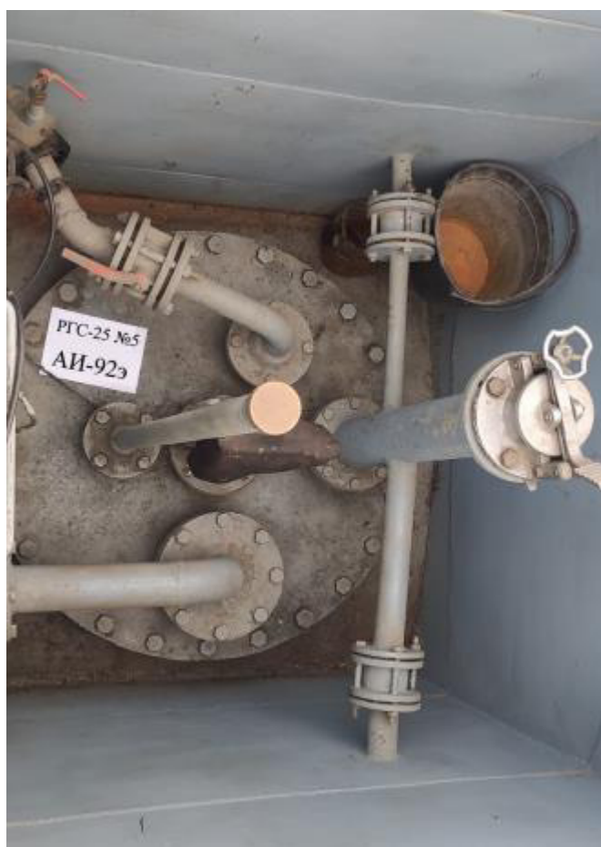
Рисунок 4 – Горловина резервуара РГС-25 зав.№ 5
