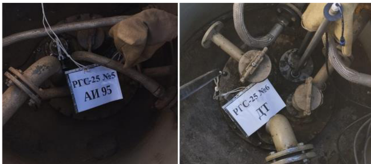
Рисунок 5 – Горловины резервуаров РГС-25 зав.№№ 5, 6
