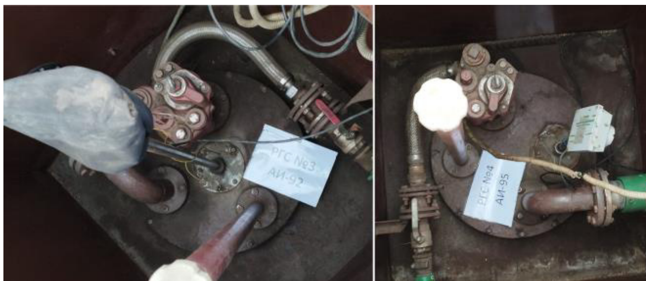
Рисунок 3 – Горловины резервуаров РГС-50 зав.№№ 3, 4
