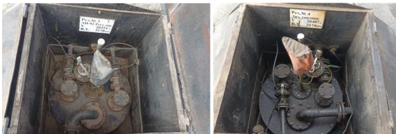
Рисунок 4 – Горловины резервуаров РГС-20 зав.№№ 3, 4
