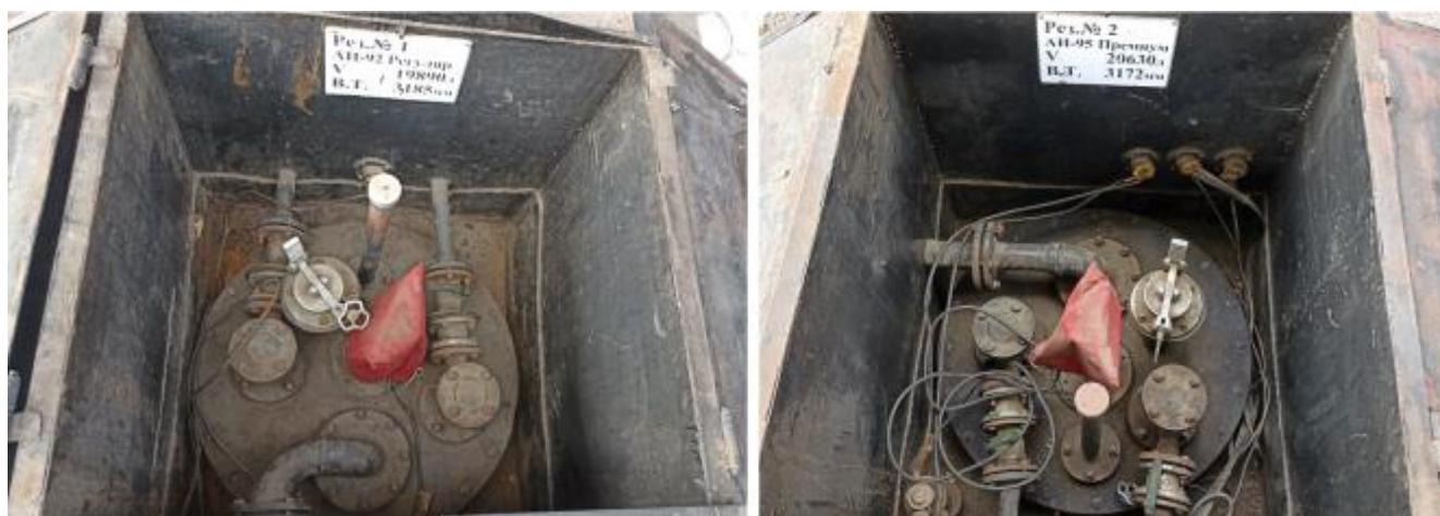
Рисунок 3 – Горловины резервуаров РГС-20 зав.№№ 1, 2
