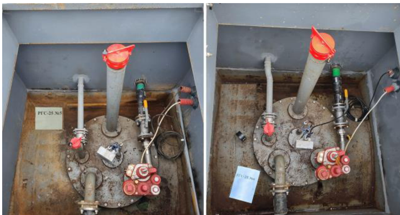
Рисунок 4 – Горловины резервуаров РТС-25 зав.№№ 5, 6
