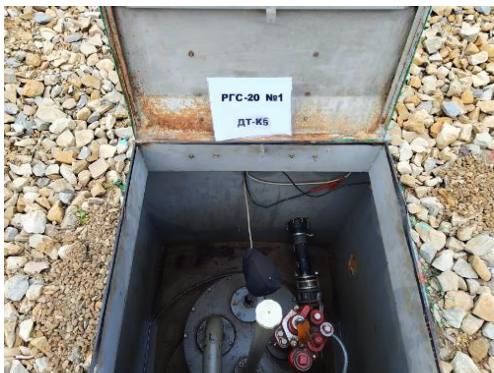
Рисунок 2 – Горловина резервуара РГС-20 зав.№ 1
