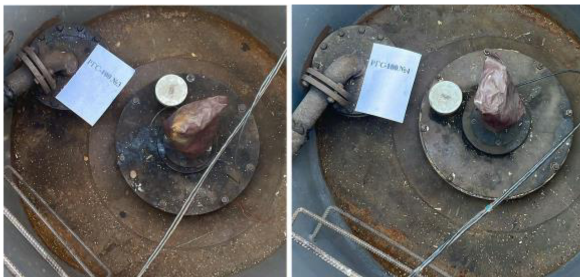
Рисунок 3 – Горловины резервуаров РГС-100 зав.№№ 3, 4
