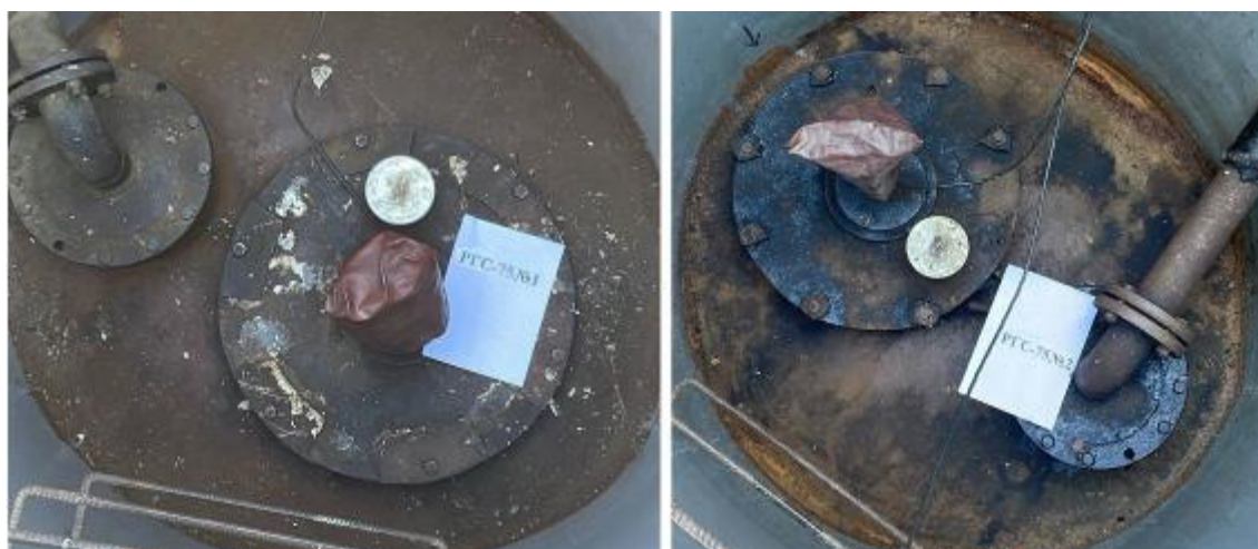
Рисунок 2 – Горловины резервуаров РГС-75 зав.№№ 1, 2
