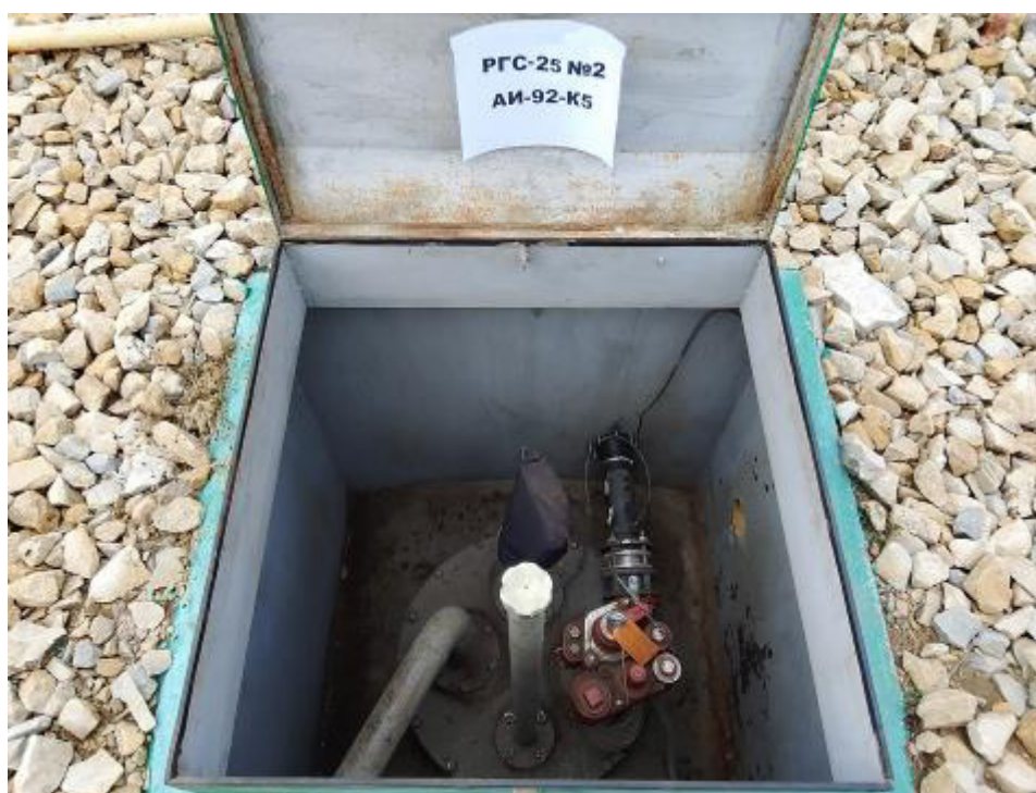
Рисунок 3 – Горловина резервуара РГС-25 зав.№ 2
