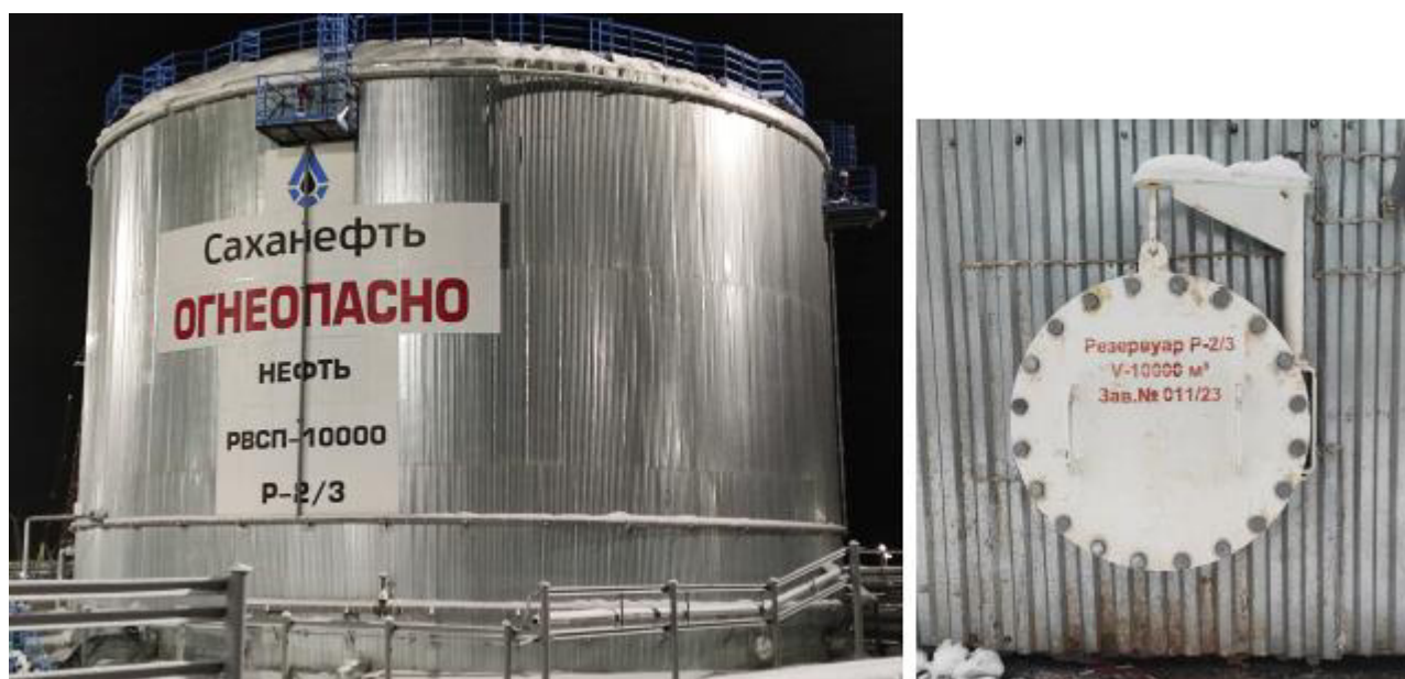
Рисунок 2 – Общий вид резервуара РВСП-10000 зав.№ 011/23 и место нанесения заводского номера
