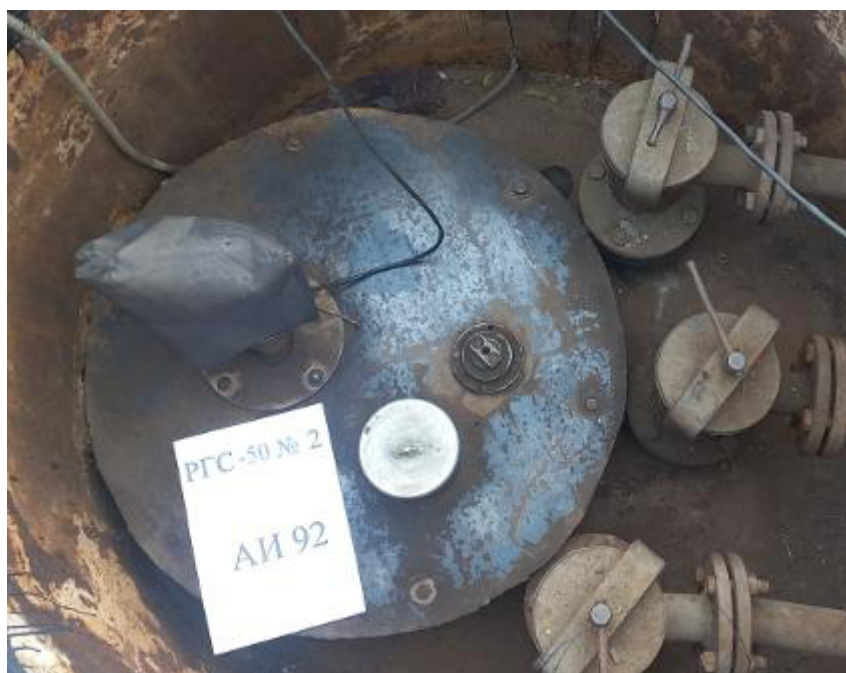
Рисунок 3 – Горловина резервуара РГС-50 зав.№ 2
