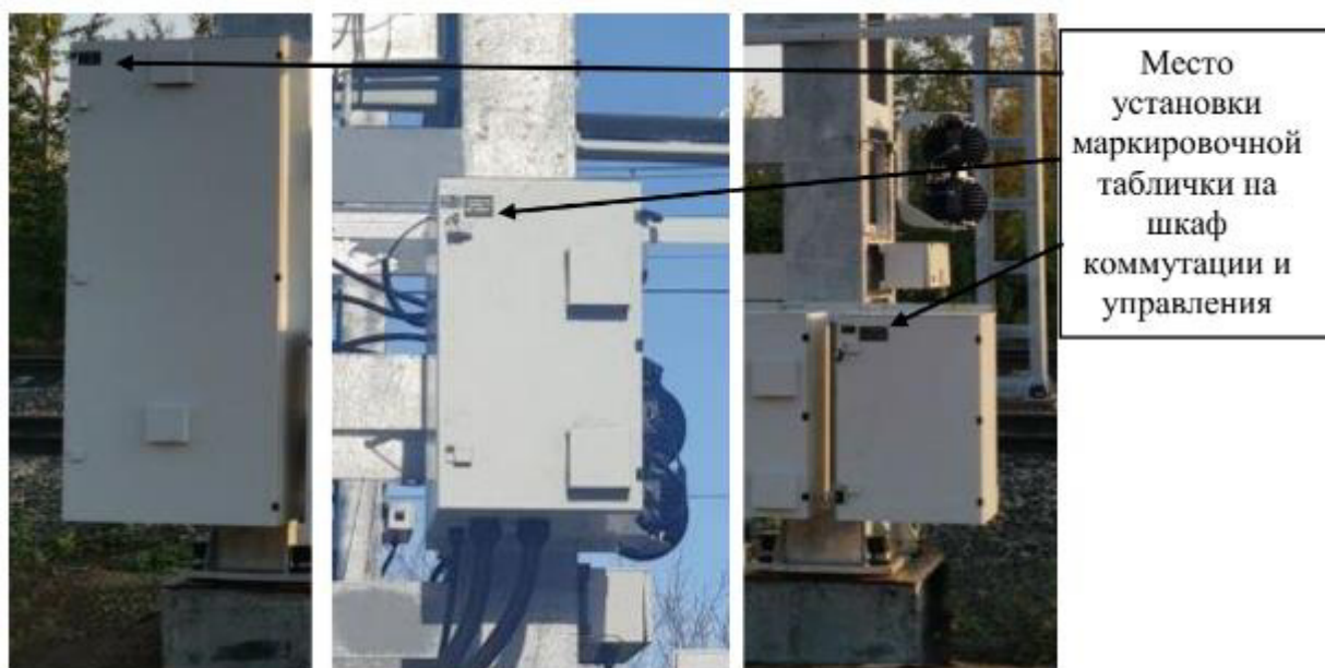
Рисунок 4 – Общий вид шкафа коммутации и управления с указанием места нанесения маркировочной таблички
