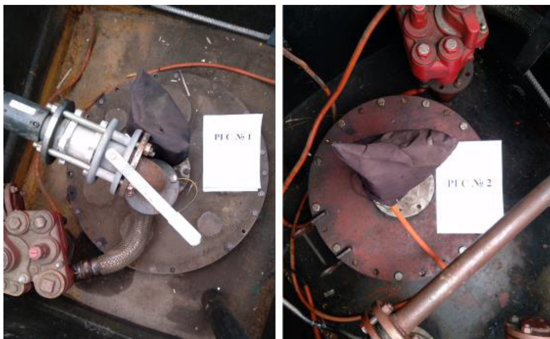
Рисунок 6 – Горловины резервуаров РГС-100 зав.№№ 1, 2
