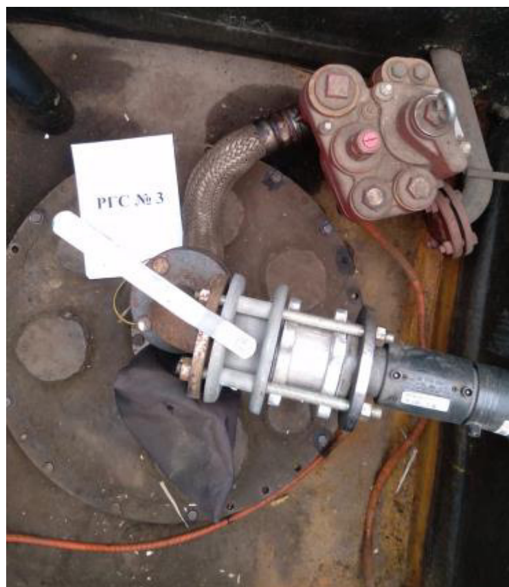
Рисунок 3 – Горловина резервуара РГС-20 зав.№ 3
