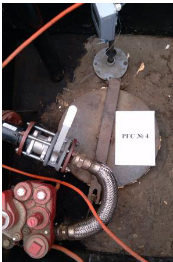
Рисунок 5 – Горловина резервуара РГС-50 зав.№ 4
