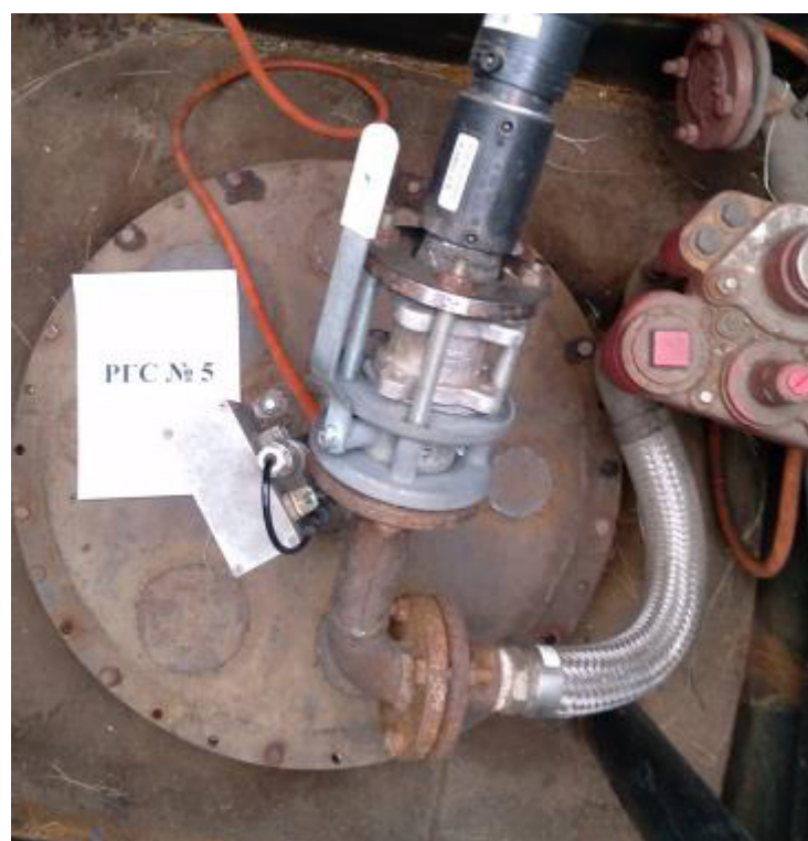
Рисунок 4 – Горловина резервуара РГС-40 зав.№ 5
