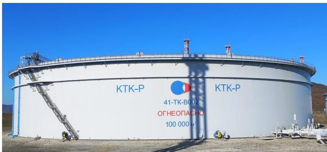
Рисунок 2 – Общий вид резервуара РВСПК-100000 зав.№ 41-ТК-В002
