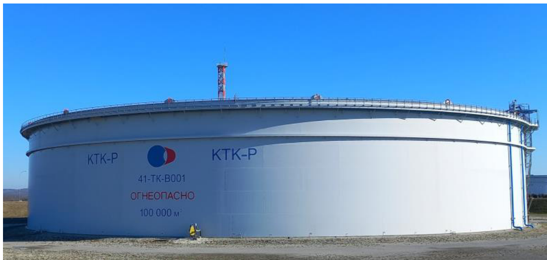
Рисунок 1 – Общий вид резервуара РВСПК-100000 зав.№ 41-ТК-В001
