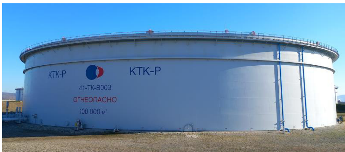
Рисунок 3 – Общий вид резервуара РВСПК-100000 зав.№ 41-ТК-В003
