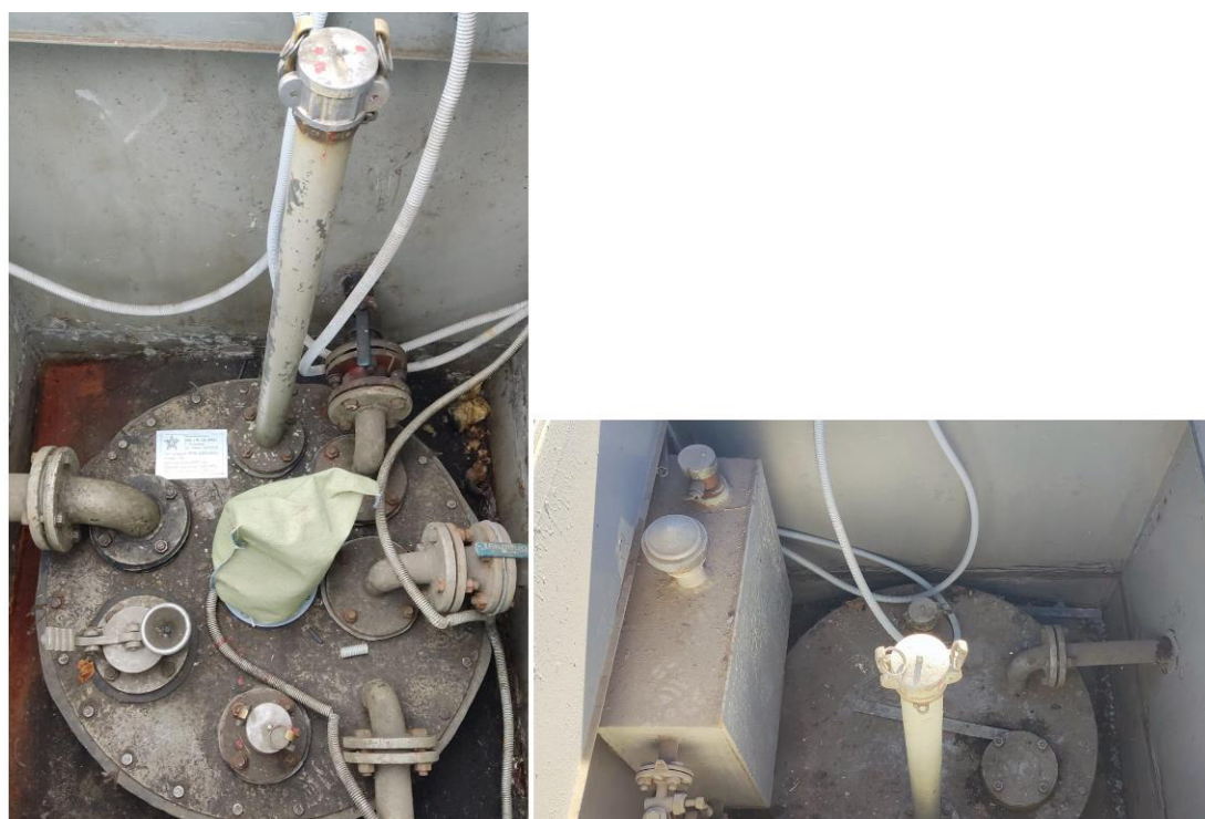
Рисунок 3 – Горловины резервуара РГ50 ((40)+(10)) зав.№ 126
