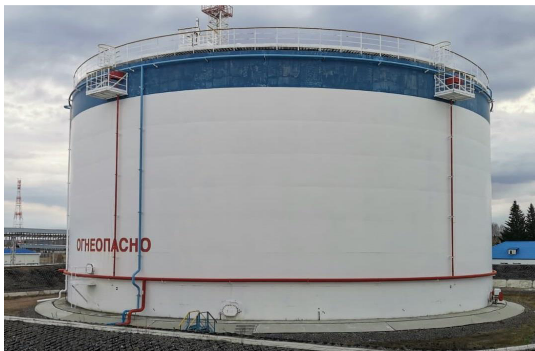
Рисунок 2 – Общий вид резервуара с заводским номером 845
