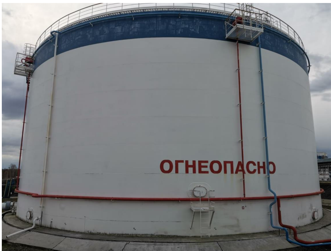
Рисунок 1 – Общий вид резервуара с заводским номером 344
