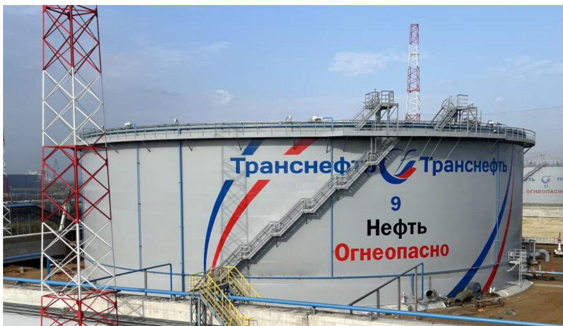
Рисунок 1 – Общий вид резервуара РВСПК-50000 № 9
