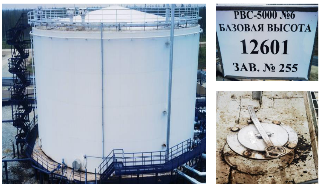
Рисунок 2 – Общий вид, замерной люк и заводской номер резервуара PBC-5000 № 255
