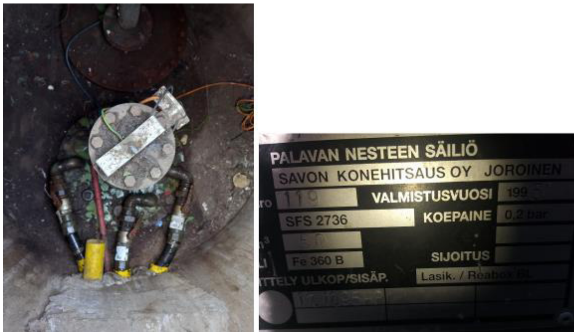
Рисунок 5 – Маркировочная табличка и горловины резервуара РГС-50 зав.№ 119
