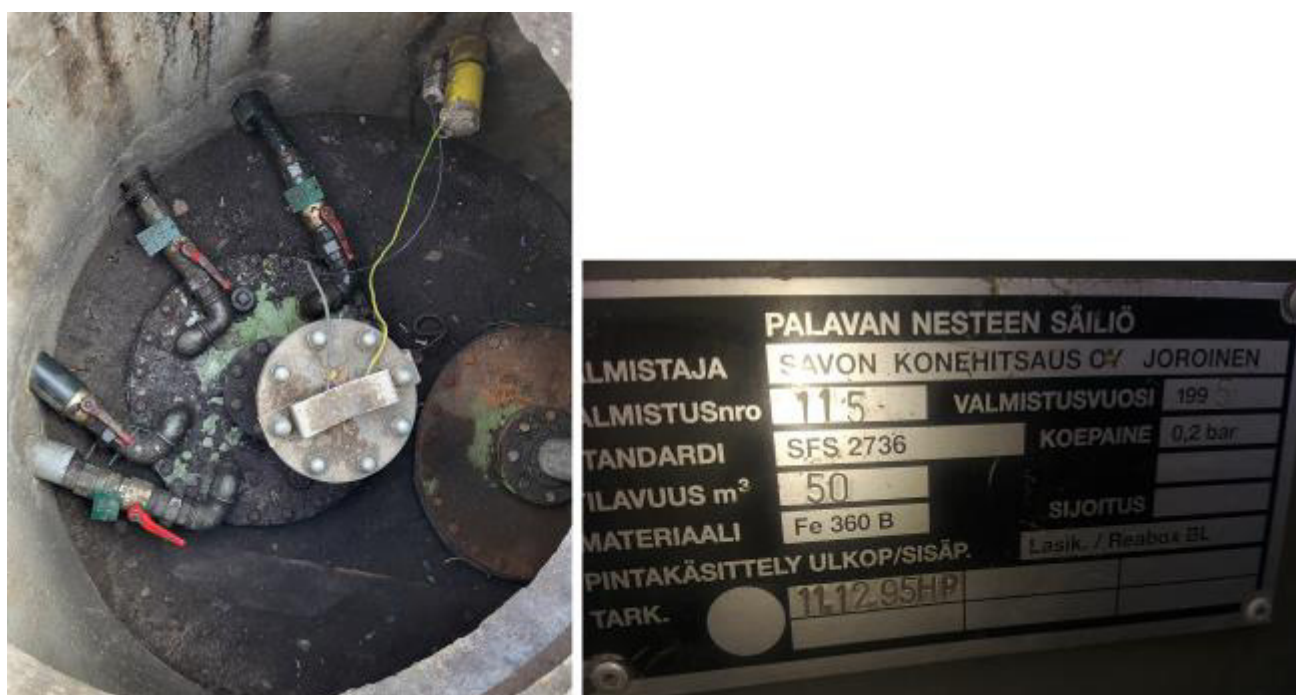
Рисунок 6 – Маркировочная табличка и горловины резервуара РГС-50 зав.№ 115
