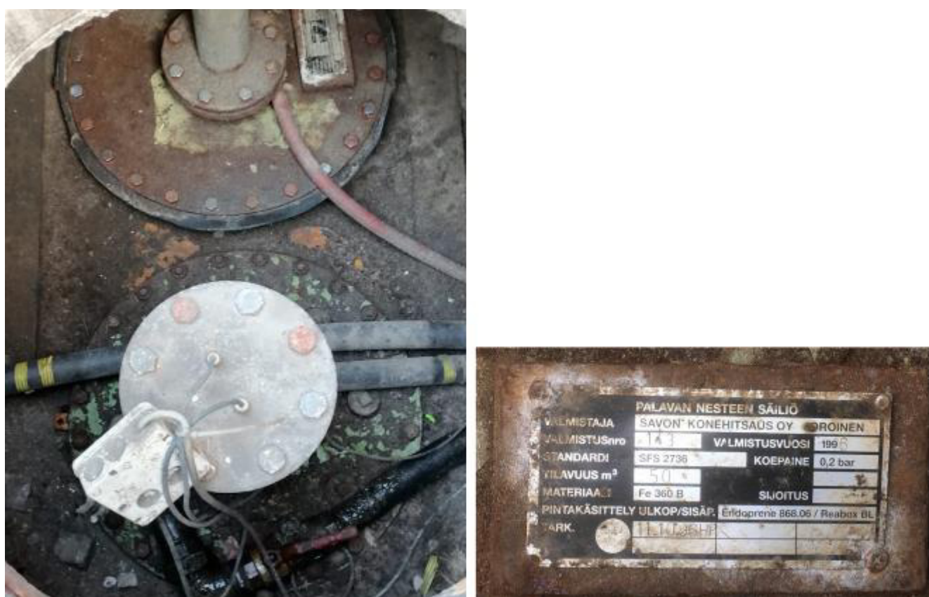
Рисунок 4 – Маркировочная табличка и горловины резервуара РГС-50 зав.№ 143
