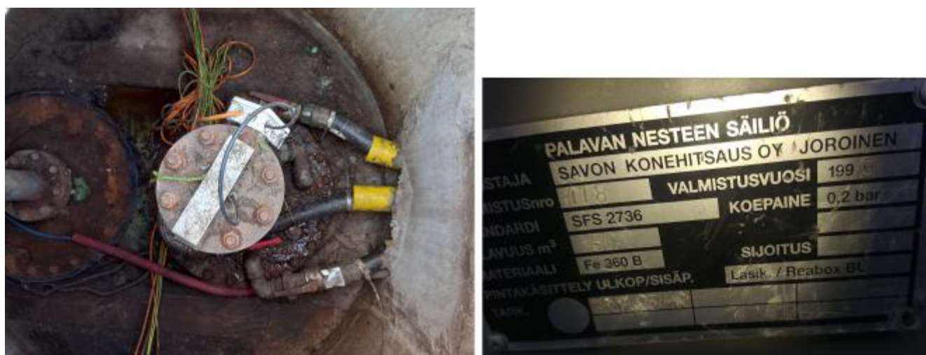
Рисунок 4 – Маркировочная табличка и горловины резервуара РГС-50 зав.№ 118
