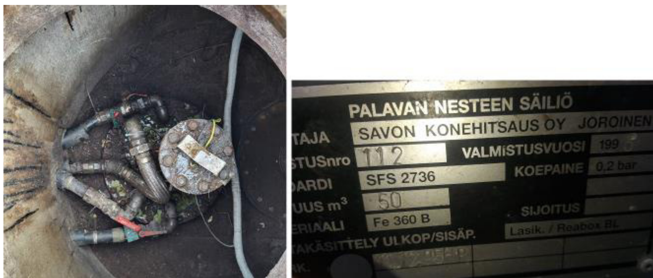
Рисунок 3 – Маркировочная табличка и горловины резервуара РГС-50 зав.№ 112
