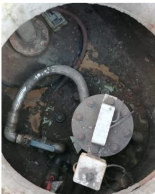
Рисунок 2 – Маркировочная табличка и горловины резервуара РГС-50 зав.№ 141
