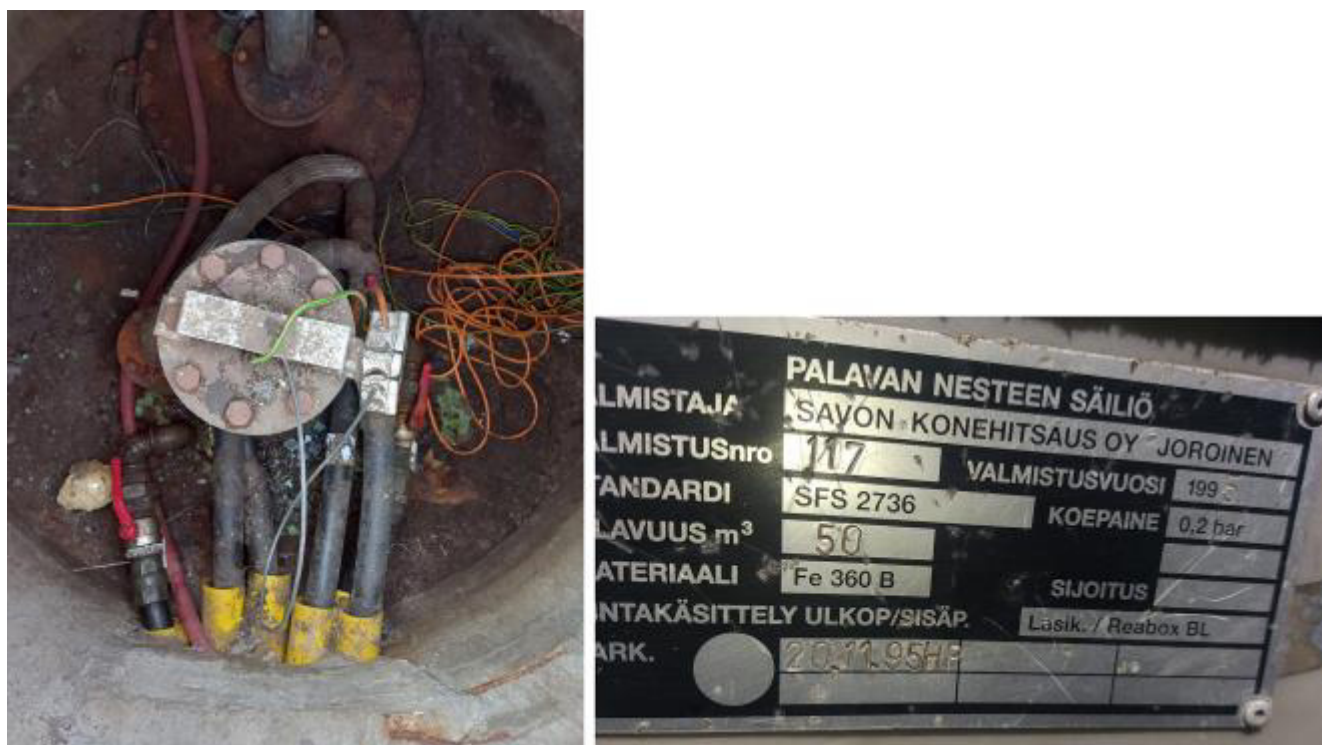
Рисунок 3 – Маркировочная табличка и горловины резервуара РГС-50 зав.№ 117
