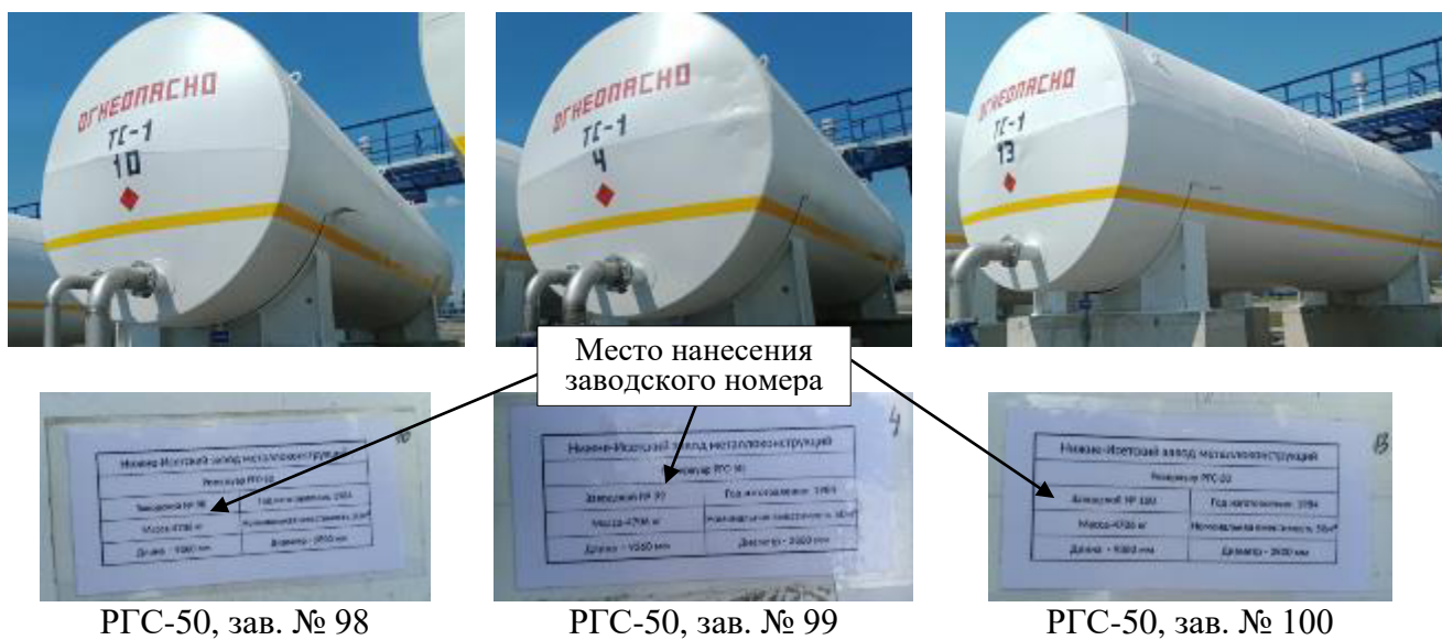
Рисунок 1 – Общий вид резервуаров модификации РГС-50, зав. №№ 98, 99, 100, табличек и мест нанесения заводских номеров
